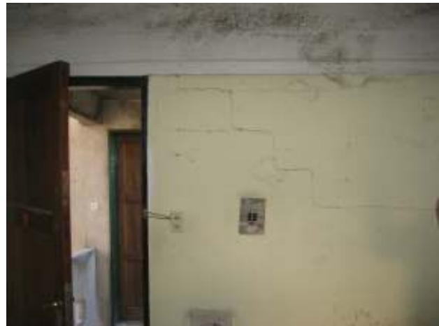
Figura 2. a. Rotulación de la columna. b. Fisura en viga fachada noroeste
