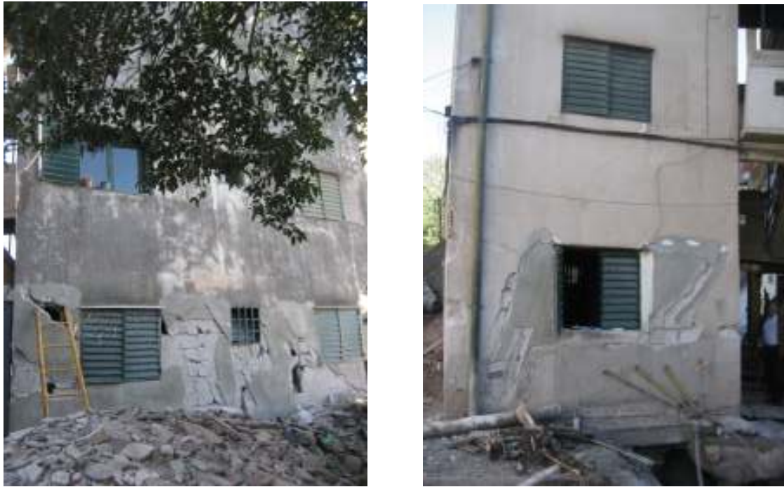
Figura 4. a.Fachada suroeste. b.Fachada Noreste
