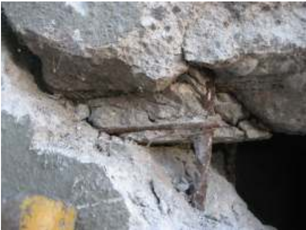
Figura 2. a. Rotulación de la columna. b. Fisura en viga fachada noroeste
