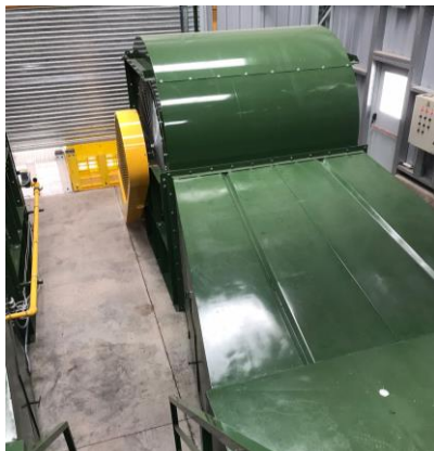
Imagen 4.16. Horno y turbina
