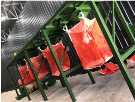
Imagen 4.18. Sector de vaciado de los cajones.
