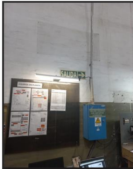
Figura 29. Imagen de señalización incorrecta
