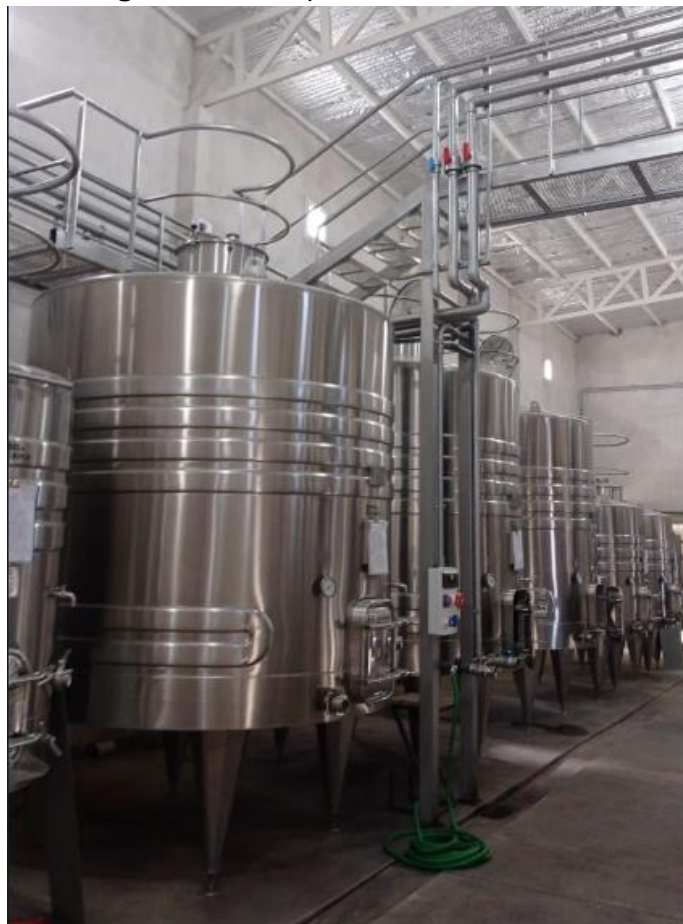
Figura 8.9: Tanques de fermentación. 50
