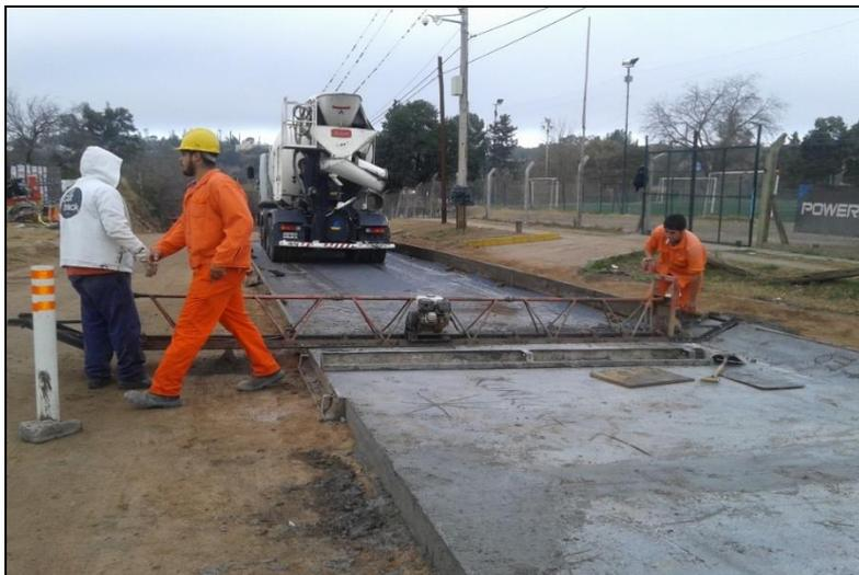
Imagen 5.25 Hormigonado en calle Gauss. Terminación mediante cinta
