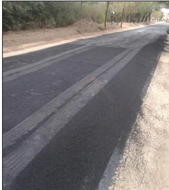
Imagen 5.21 Distribución, ejecución y compactación de capa arena-asfalto. Calle Newton
