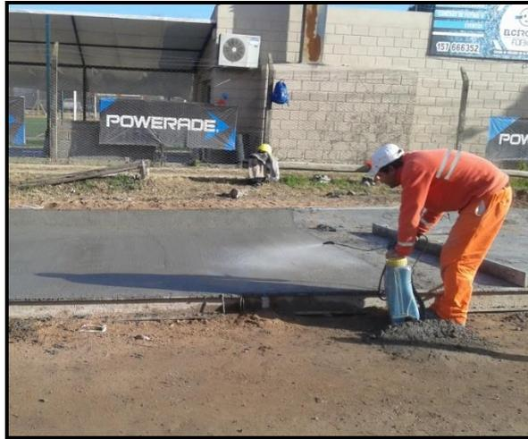
Imagen 5.26 Curado de losa mediante antisol
