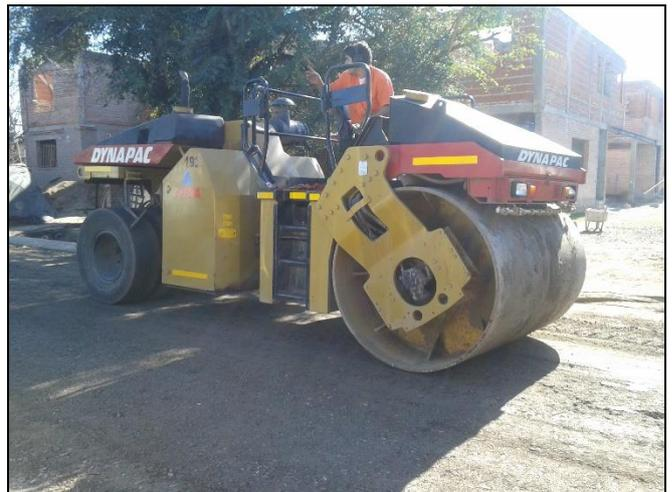
Imagen 5.15 Ejecución base granular calle Newton
