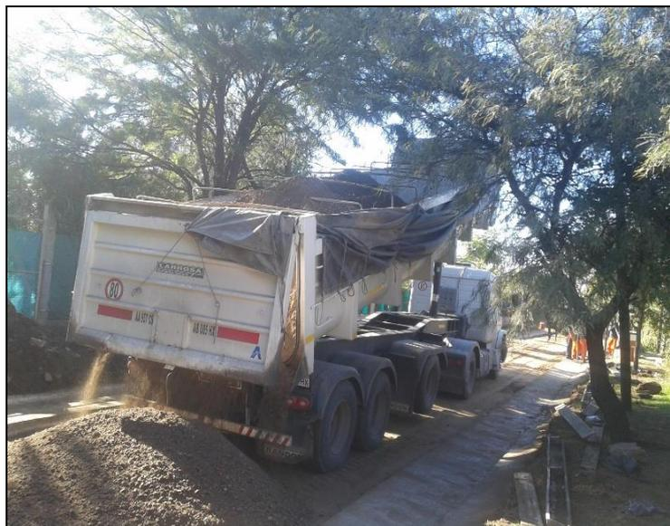
Imagen 5.14 Descarga de material para base en calle Newton
