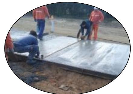
Luego se le realizó el curado a la losa con agua y antisol (Imagen 5.26). La primera se encarga de provisionarle al hormigón la humedad que requiere, para un fragüe controlado y evitar la segregación del material granular, mientras que el antisol lo que hace es brindar impermeabilidad, evitando que las partículas en suspensión se depositen sobre el hormigón en estado fresco, ya que se comprobó en la práctica
