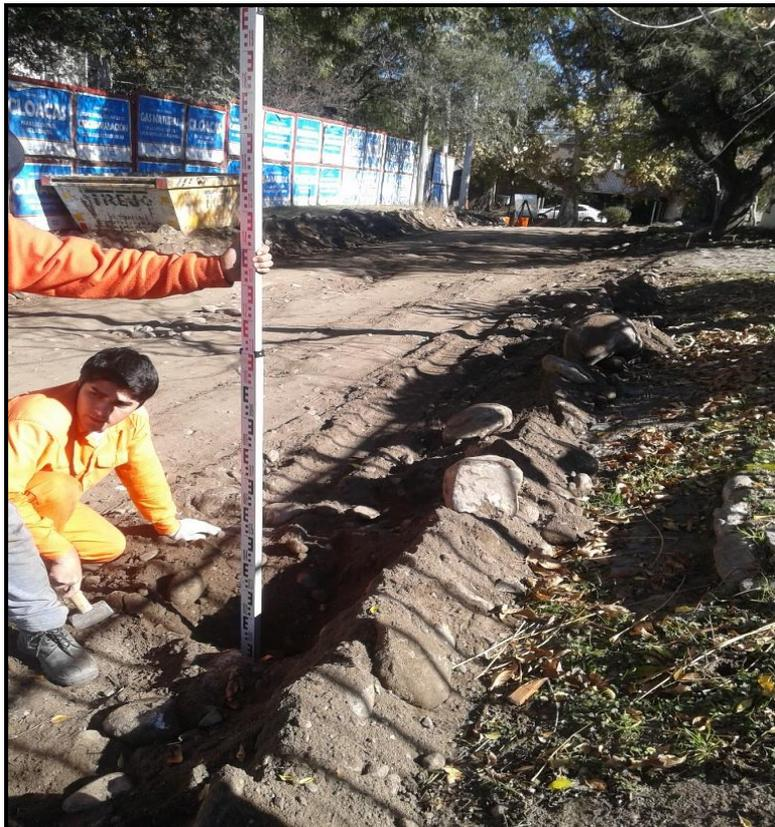
Imagen 5.7 Determinación de la cota de subrasante superior a la final
