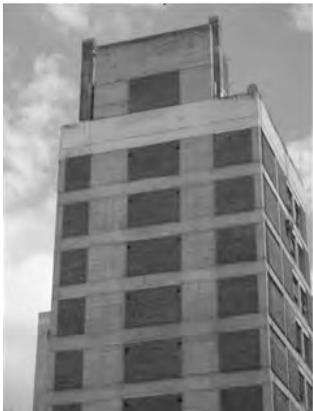
Fig. 17 - Ductilidad 4 - Tabiques vinculados entre sí
