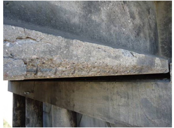
Figura 5. Viga V1 – Cara Norte
