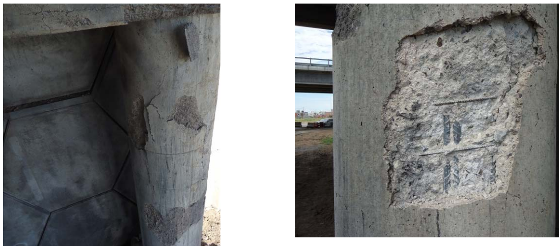
Figura 2. Columna C1 del Estribo Oeste del Puente N° 2
