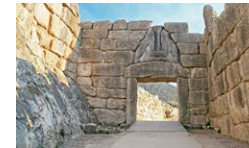
Micenas es una de las primeras ciudades del mundo griego arcaico: sus murallas construidas con grandes piedras y según la mitología griega construidas por el Ciclope (personaje de fuerza extraordinaria con un solo ojo) dan nombre al hormigón ciclópeo, o sea el hormigón donde el componente grueso son piedras de gran tamaño. Fuente: Fotos del autor.
