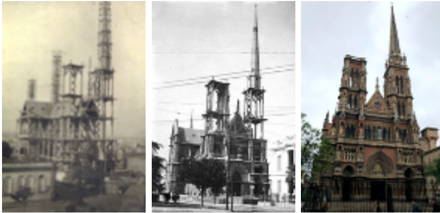
Iglesia del Sagrado Corazón de la orden de los monjes franciscanos capuchinos en el Barrio de Nueva Córdoba-Córdoba. Fue proyectada por el arquitecto Augusto Ferraris en 1926.
