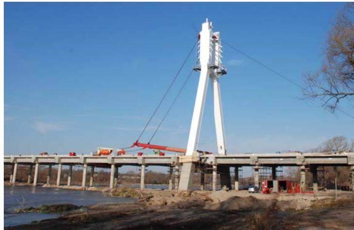
Figura N°3: Fotografía del Montaje de la Pila Metálica (vista Lateral)
