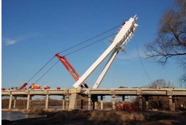
Figura N°2: Fotografía del Montaje de la Pila Metálica (vista Lateral)
