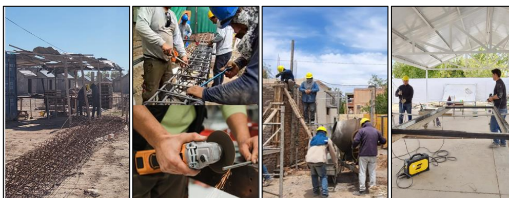
Figura 14 – Inexistencia de señalética de precaución – Ausencia de EPP
