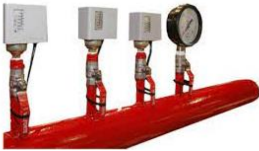
Ubicación de presostatos y manómetro
