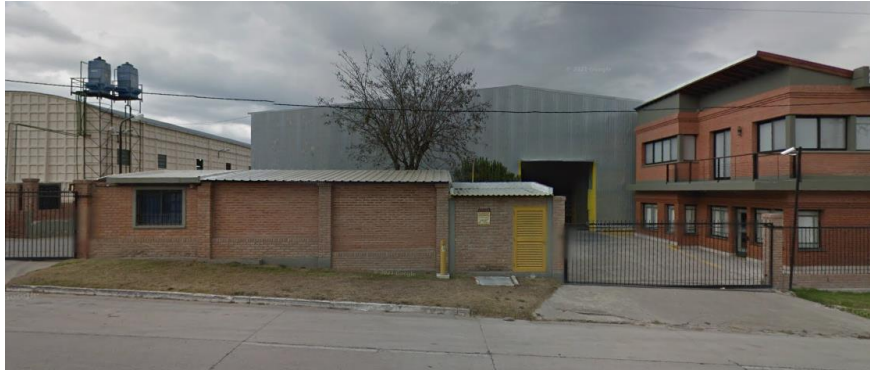
Acometida gas natural por calle Gardel
