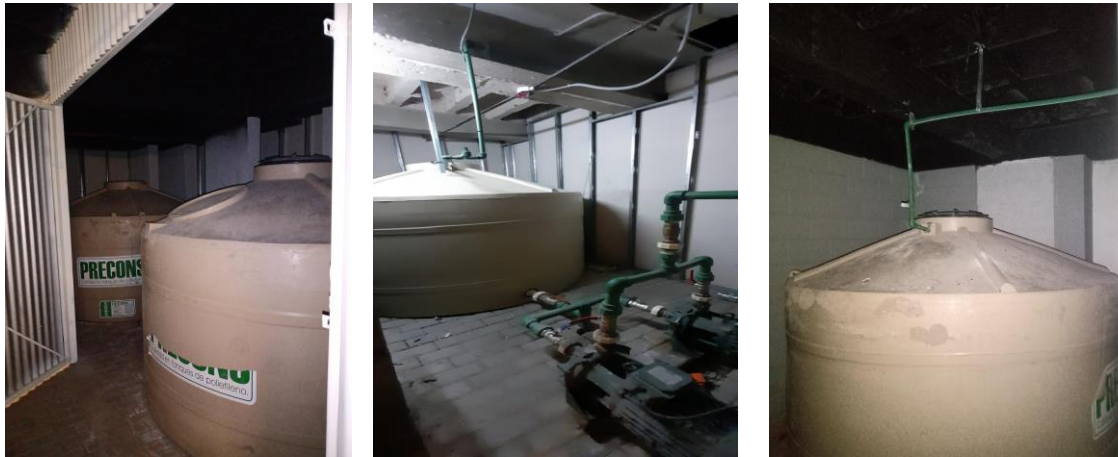
Figuras 1.6.3 - 1.6.4 – 1.6.5 Sistema agua fría y caliente
