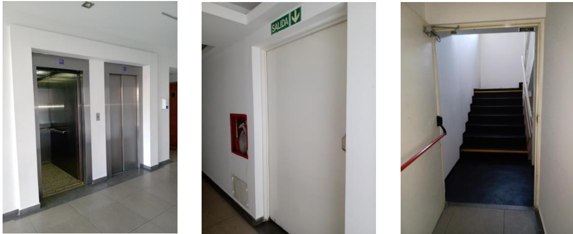
Figuras 1.6.9 - 1.6.10 – 1.6.11 Medios mecánicos de elevación y caja de escaleras
