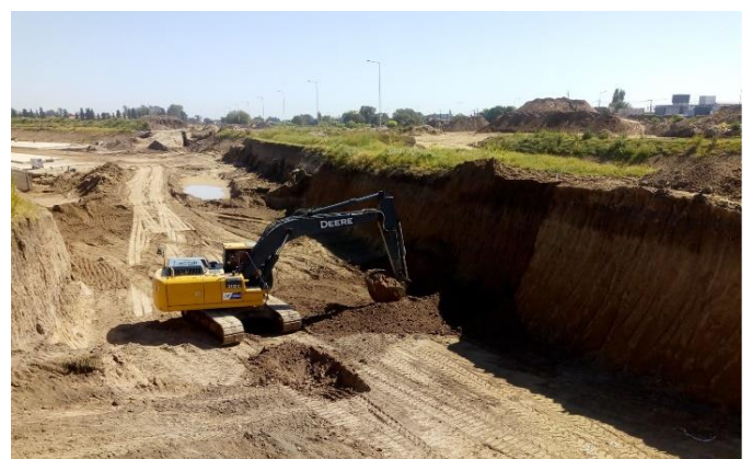
Ilustración 18 - Maquinaria en obra – Excavación de zanja
