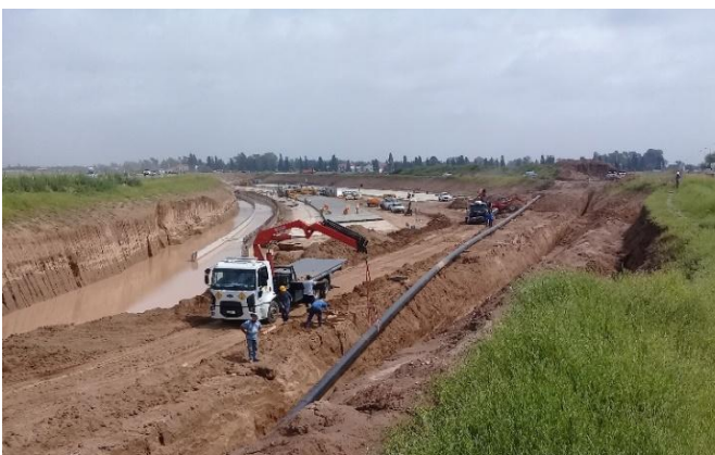
Ilustración 15 - Maquinaria en obra, movimiento de cañerías
