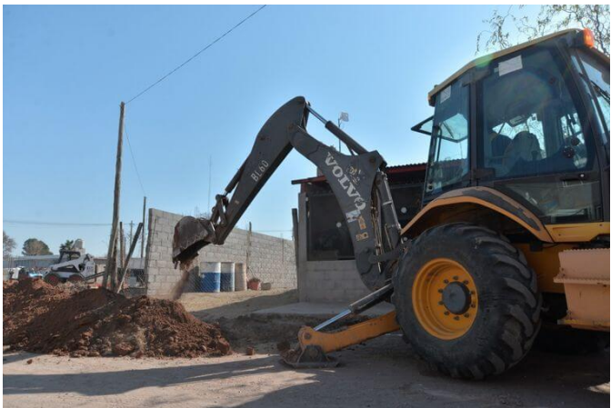
Ilustración 19 – Excavación de terreno
