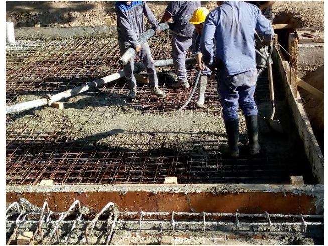
Ilustración 24 - Hormigonado de plateas
