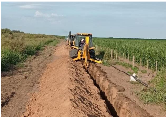
Ilustración 21 - Excavación con maquinarias - desnivel
