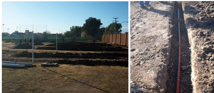
Figura 5 - Materialización del sistema de riego
