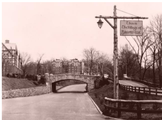
Figura N° 16. Los pasos elevados diseñados por el constructor Robert Moses en Long Island, estados unidos. Recuperado de Bloomberg.com ( https://www.bloomberg.com/news/articles/2017-07-09/robert-moses-and-his-racist-parkway-explained ). Estas construcciones estaban pensadas y diseñadas a cierta altura para evitar el paso de autobuses y, de esta manera, restringir la circulación de ciertos grupos sociales que utilizaban este tipo de transporte en lugar del automóvil, más propio de la clase social alta. Con este ejemplo, Winner ilustra el primer argumento de tecnologías que se ejercen como formas de orden político y social.
