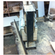
Construcción. Image Courtesy of estudio JONNY GALLARDO
