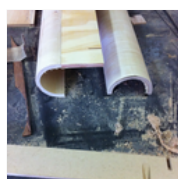
Construcción. Image Courtesy of estudio JONNY GALLARDO
