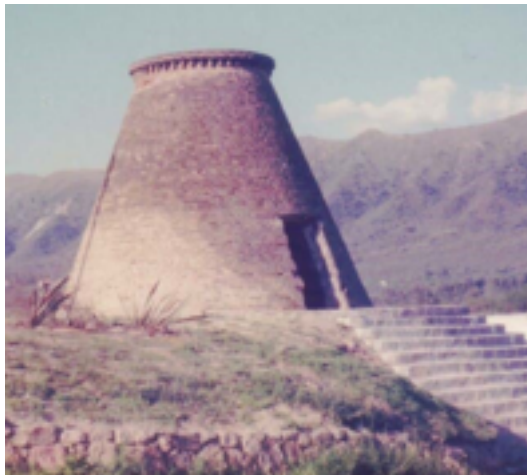
Figura 5. Horno de la fábrica La Primera Argentina ubicada sobre el río Cosquín en la localidad Bialet Massé.
