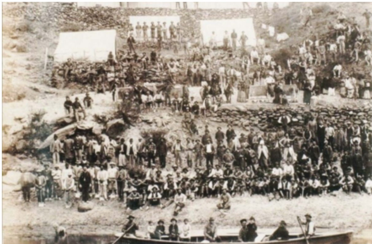
Figura 4. Obreros trabajando en la construcción del viejo Dique San Roque (1887).
