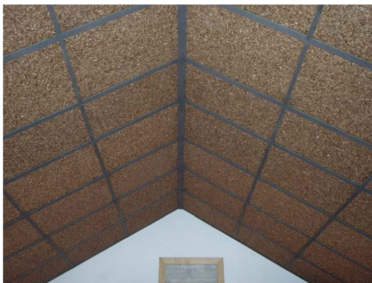
Fig. 142: Vista resultante de las placas de cielorraso con cáscaras de maní y resina poliéster
