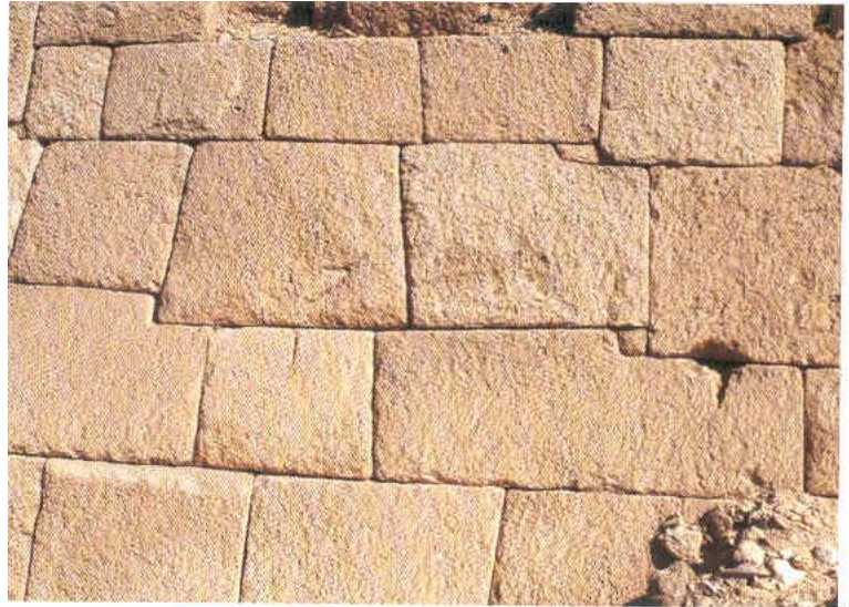
Fig 12 a y b: Mampostería unida con piezas irregulares en la pirámide de Gizah, cerca de El Cairo. Fuente: Weston, 2003
