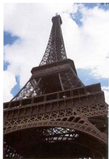
Figura 17: Torre Eiffel Fuente: Weston, 2003
