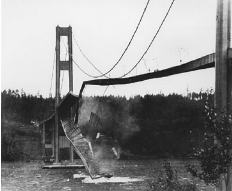
Figura 6.36: Colapso del puente de Tacoma Narrows. Imagen de dominio público obtenida de Wikipedia.
