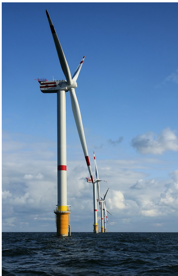
Figura 1.1: Granja eólica Thorntonbank con turbinas comerciales modelo REpower de 5 MW en el mar del norte. © Hans Hillewaert
