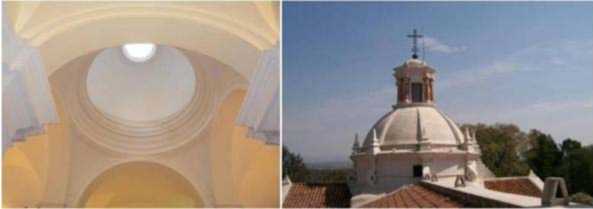
Figura 4. Vista interior y exterior de la cúpula de la Iglesia
