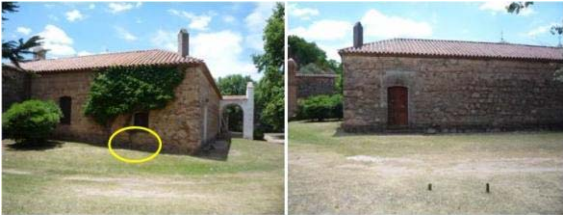
Figura 11. Vistas de habitación D9 y ubicación de pozo tangente realizado
