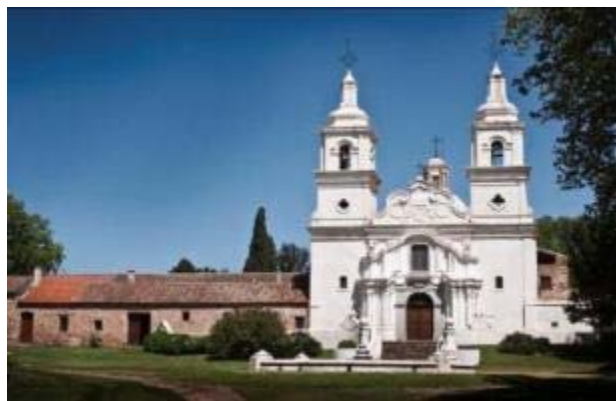
Figura 2. Fachada principal de la Iglesia
