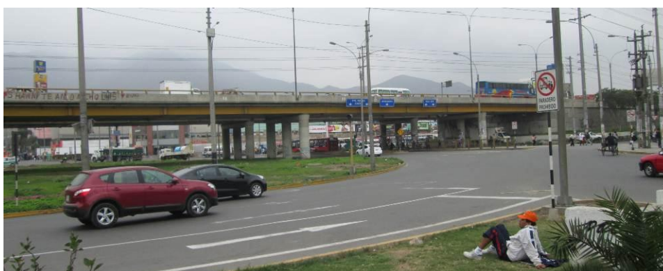
Figura 12. Vista general del puente
