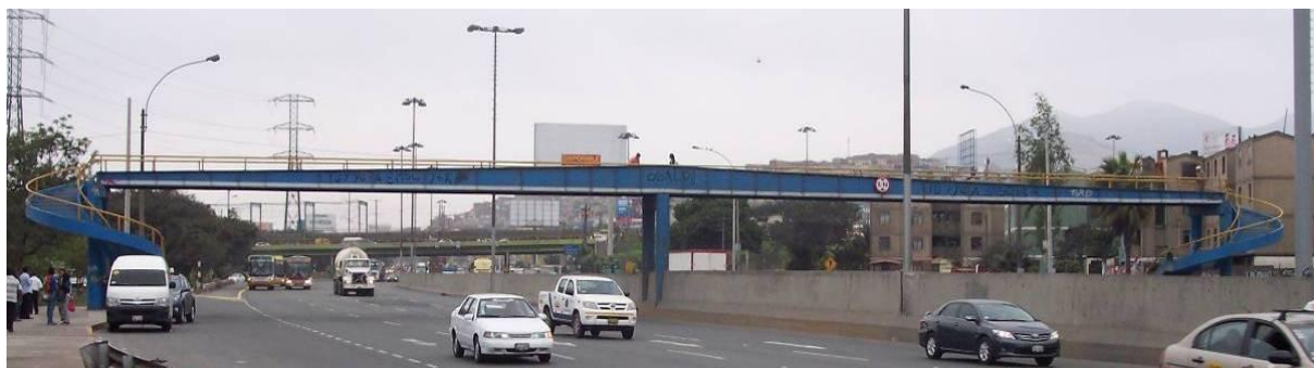
Figura 6. Vista general del puente peatonal
