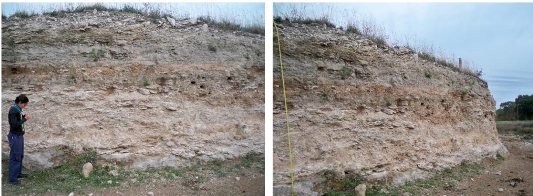
Figura 12. Imágenes del perfil de zona no saturada cercano al arroyo.
