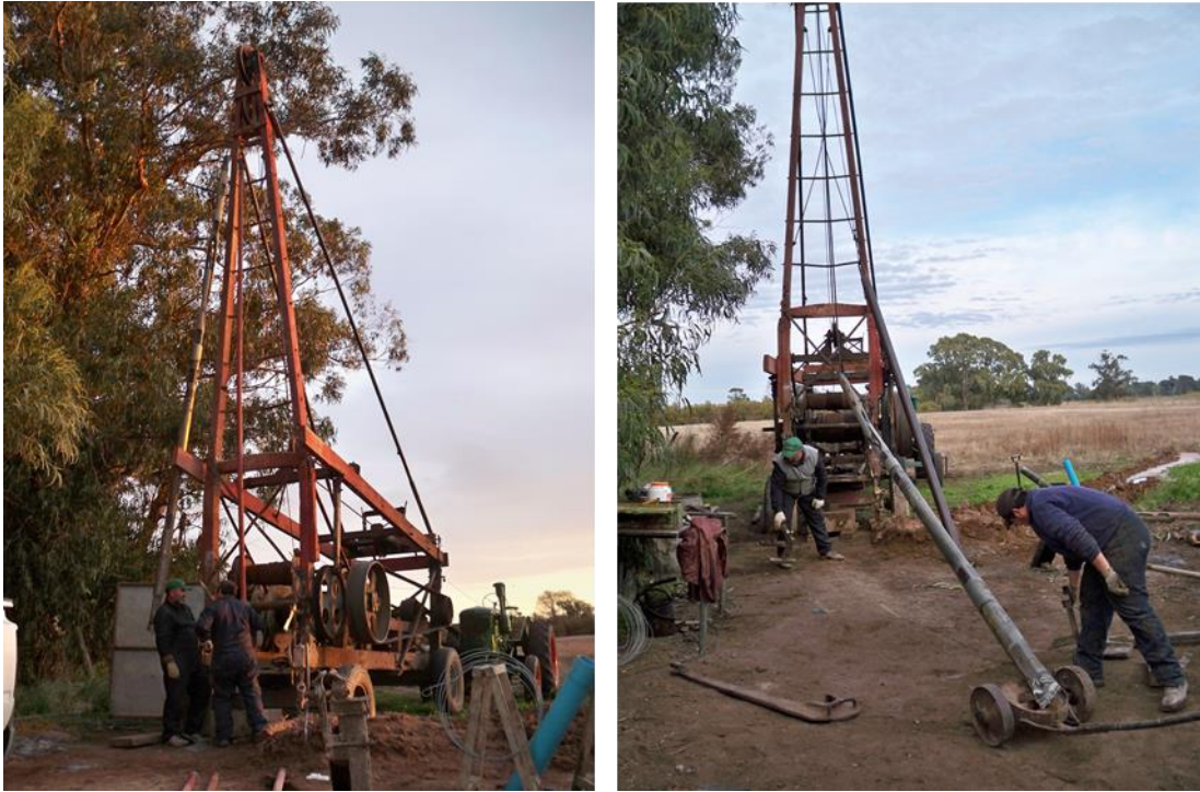
Figura 10. Imágenes durante la perforación del Pozo Piloto con equipo rotopercutor.
