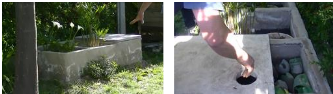
Cámaras Construidas por un Vecino para Tratamiento de Aguas Grises
