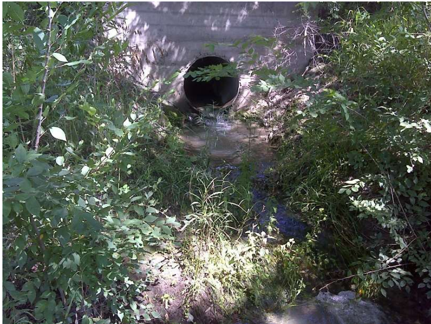
Figura 3.09 - Relevamiento Cantesur – Alcantarilla
