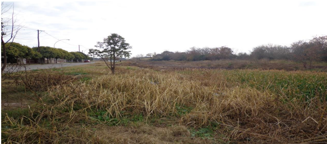
Pileta de desagüe de la planta de tratamiento de líquidos cloacales. . Fuente: archivo personal del autor. Año 2016.
