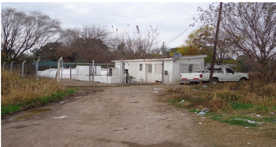
Planta de tratamiento de líquidos cloacales. . Fuente: archivo personal del autor. Año 2016.
