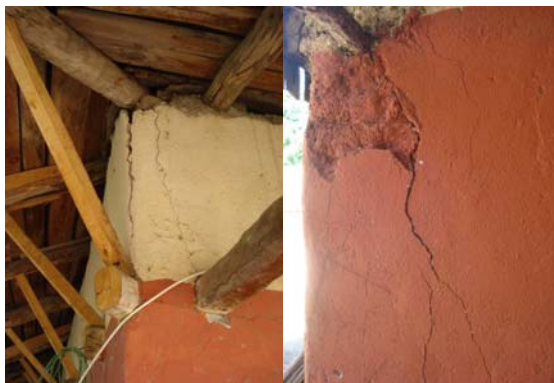
Fotografía 7. Unión techo con muros.
