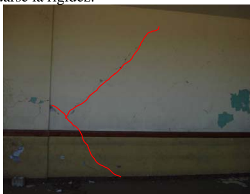
Fotografía 13. Muro de mampostería encadenada en primer piso.
