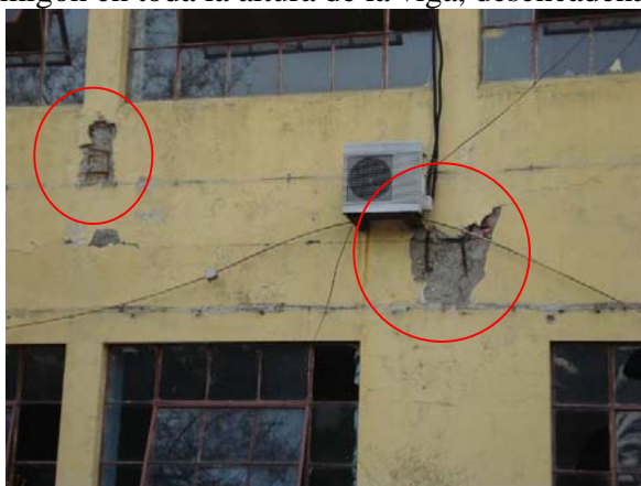
Fotografía 8. Conexión viga-columna.
