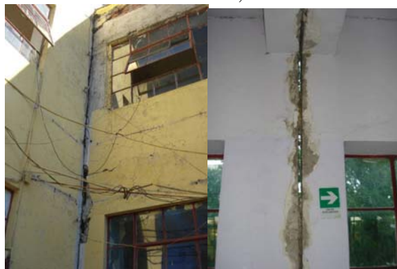
Fotografía 10. Juntas sísmicas.
