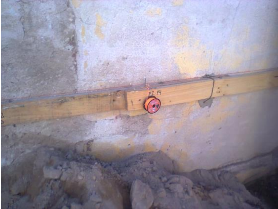
Figura 4.16: Tareas de replanteo, se observa el corralito de madera.
