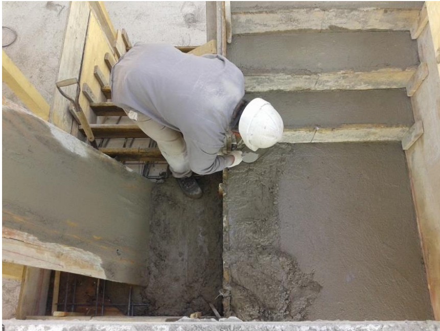
Figura 3.19: Operario realizando tareas de hormigonado.
