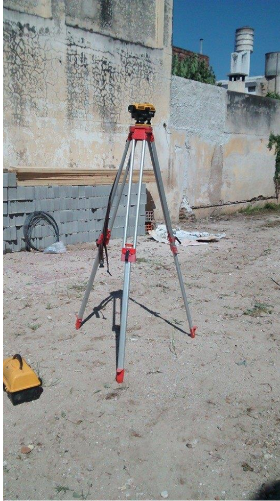
Figura 4.15: Nivel empleado en la nivelación topográfica.
