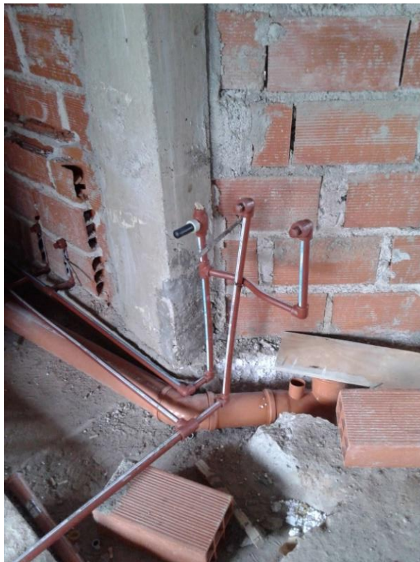
Figura 3.25: Instalaciones de agua, cloacal y pluvial.
