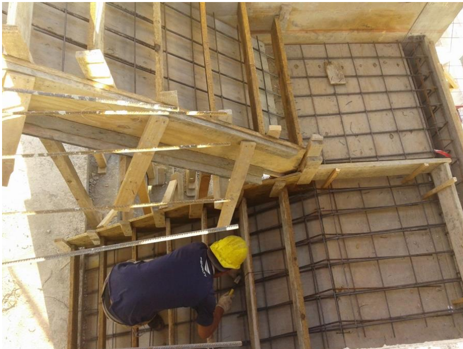
Figura 3.12: Encofrado y armado escalera.
