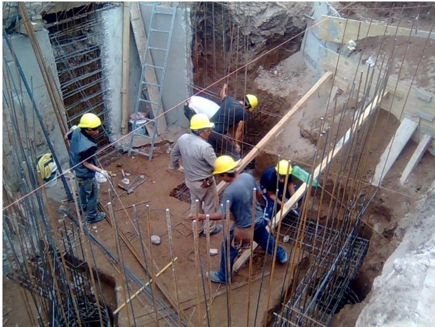
Figura 4.23: Armado de tabiques de subsuelo.
