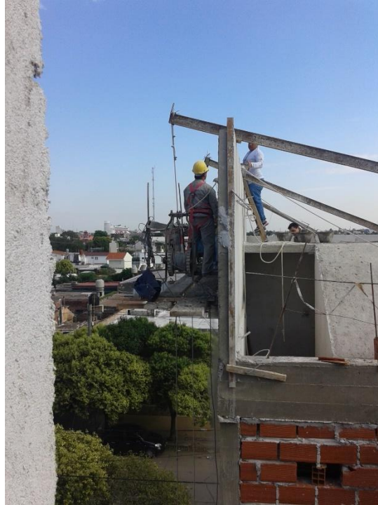
Figura 3.33: Obrero realizando revoque exterior sobre andamio.
