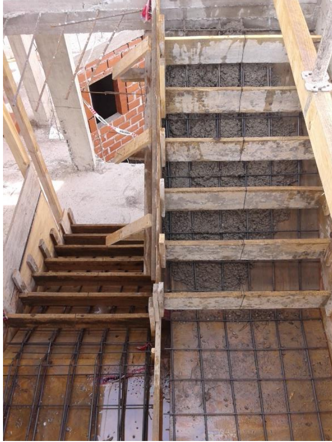
Figura 3.18: Hormigonado escalera.
