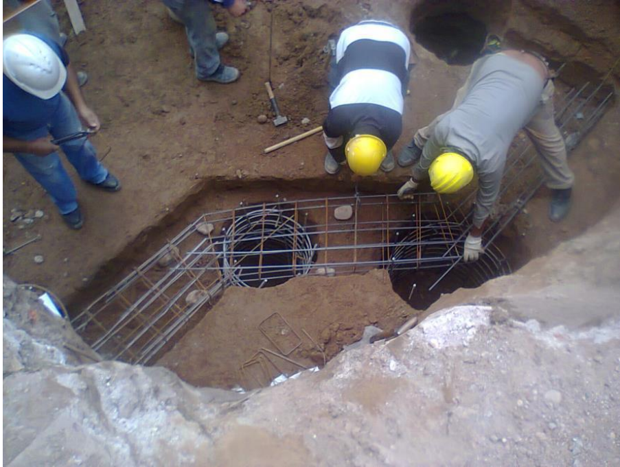
Figura 4.22: Pilotes y zapata de tabiques de subsuelo.
