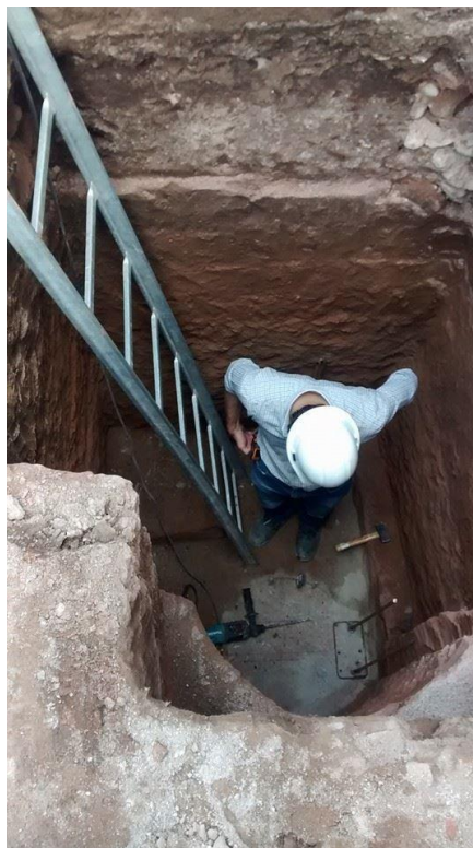
Figura 4.17: Excavación de subsuelo, se observa el suelo humedecido, producto de la lluvia.
