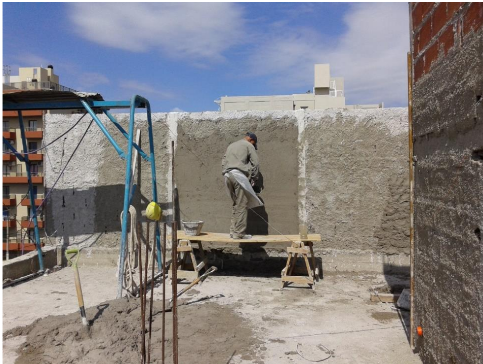
Figura 3.34: Obrero sobre andamio haciendo tareas de revoque.
