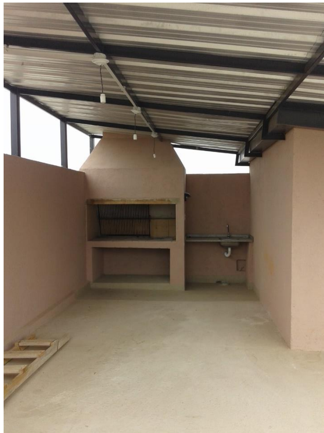
Figura 2.15: Terraza edificio "Uarte de la Mancha I"
