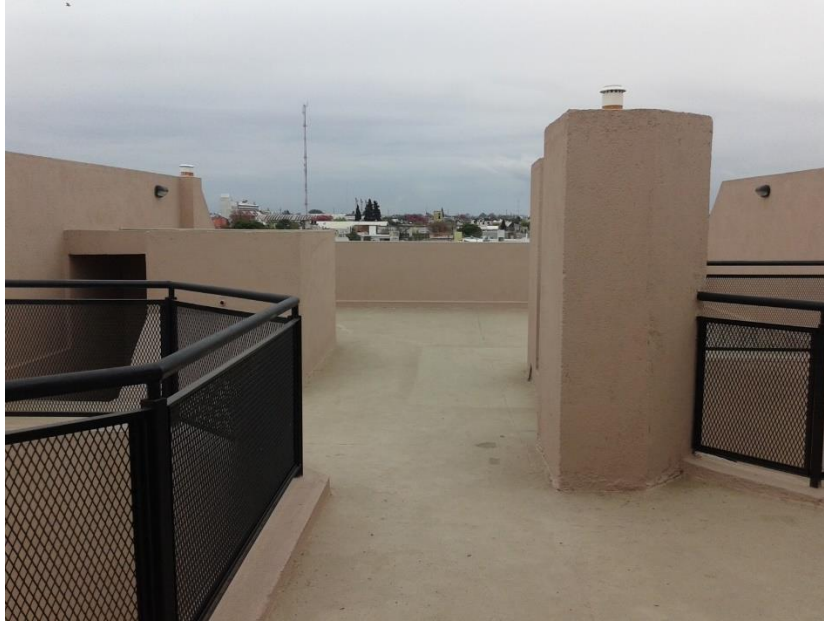
Figura 2.14: Terraza edificio "Uarte de la Mancha I"
