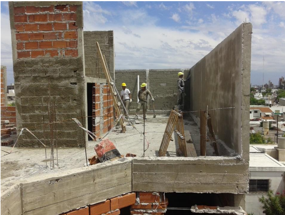
Figura 3.36: Albañiles efectuando tareas de revoque grueso en la terraza del edificio.
