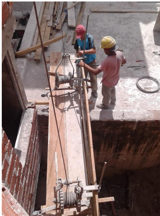
Figura 3.32: Preparación de andamio para revoque exterior.
