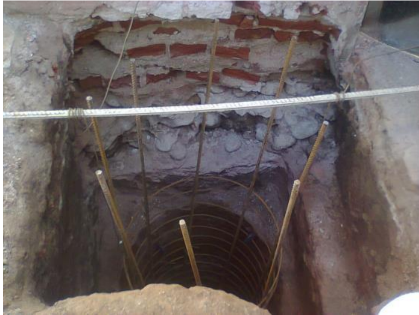
Figura 4.19: Pilote con armadura, a espera de ser hormigonado.
