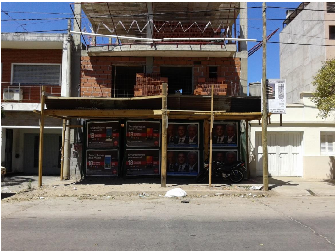
Figura 2.2: Fotografía del frente del edificio.
