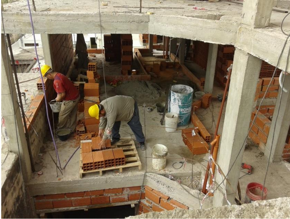
Figura 3.3: Construcción de muros e izado de ladrillos.
