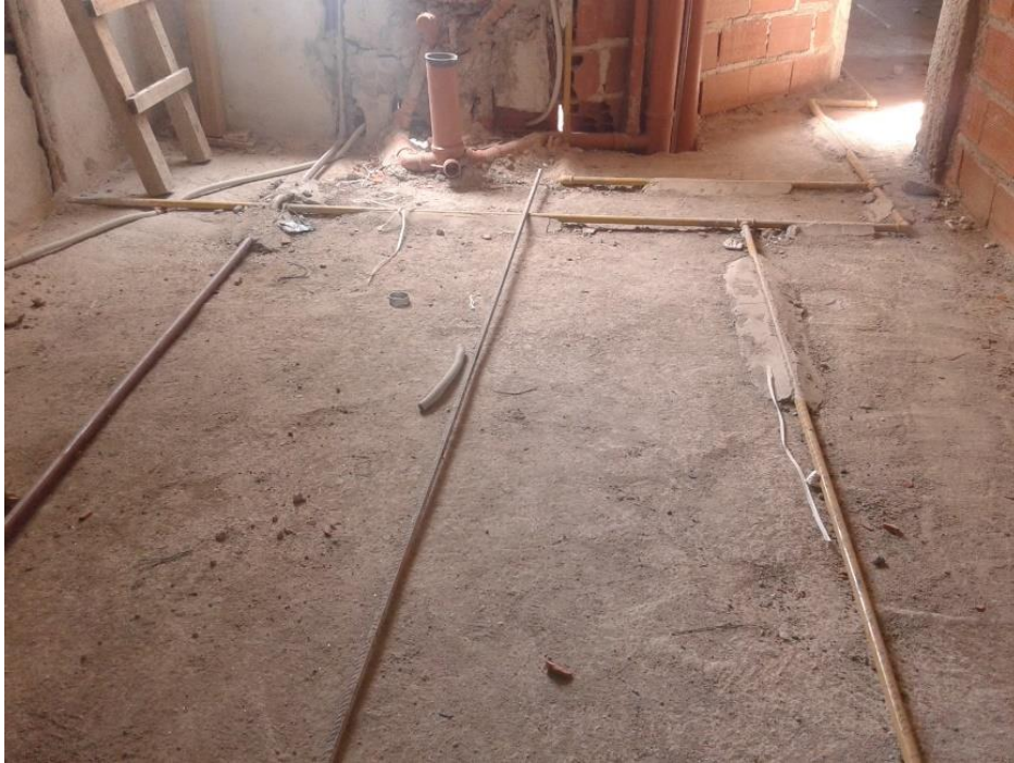
Figura 3.24: Instalaciones de gas, agua, cloacal y pluvial.
