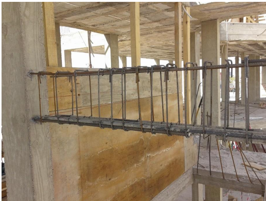
Figura 3.10: Armadura viga de escalera.
