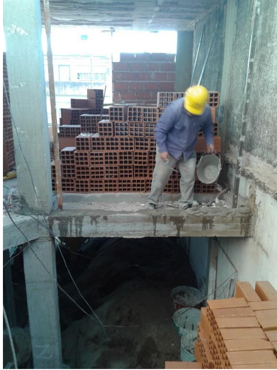
Figura 3.1: Tareas de mampostería.
