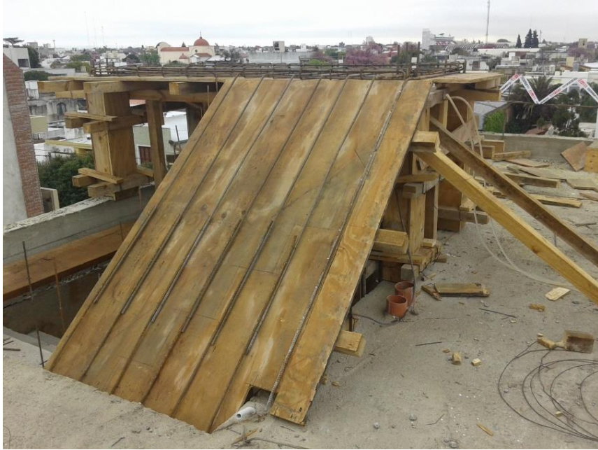
Figura 3.7: Encofrado y armado de columnas y losas de último tramo de escalera.
