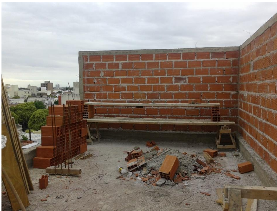
Figura 3.30: Andamio para revocar, en terraza.
