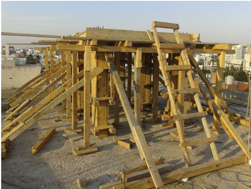
Figura 3.14: Encofrado de losa tanques de agua.
