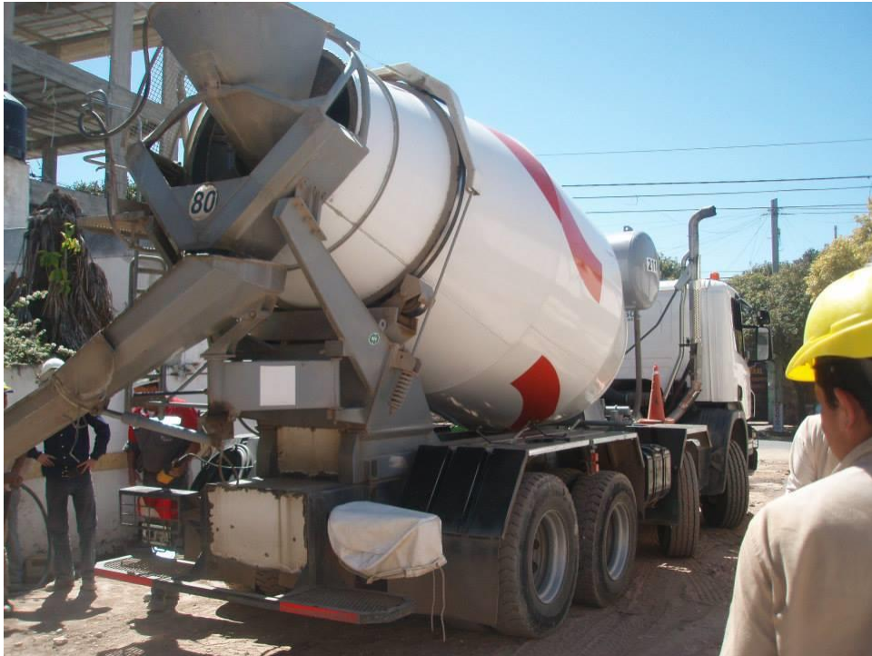
Figura 4.21: Hormigonado de pilotes.
