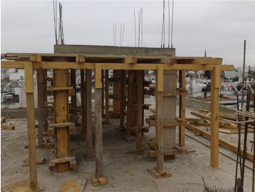
Figura 3.20: Losa y columnas de apoyo para tanques de agua.
