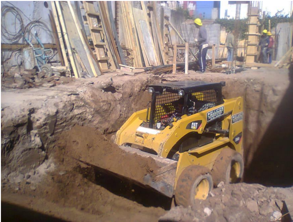
Figura 4.18: Excavación de subsuelo con mini cargadora.
