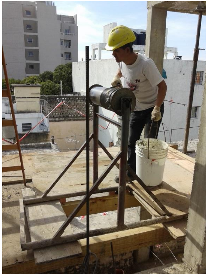
Figura 3.17: Izado de hormigón con rolo.
