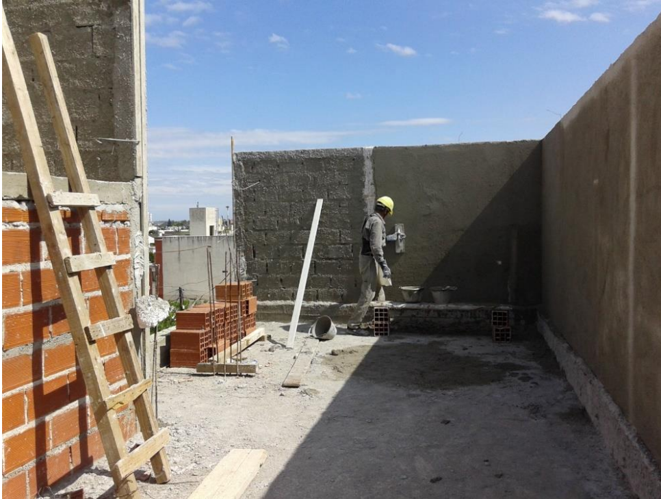
Figura 3.35: Obrero haciendo el fratasado del revoque de azotea.
