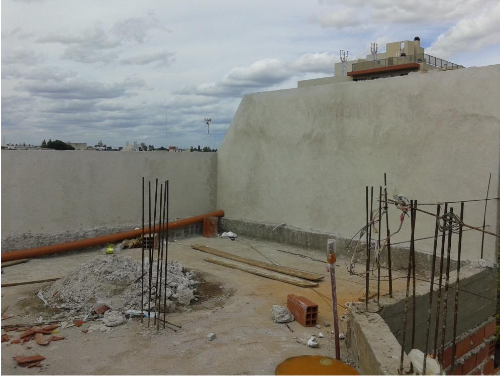
Figura 3.37: Jaharro exterior terminado en muros de azotea.
