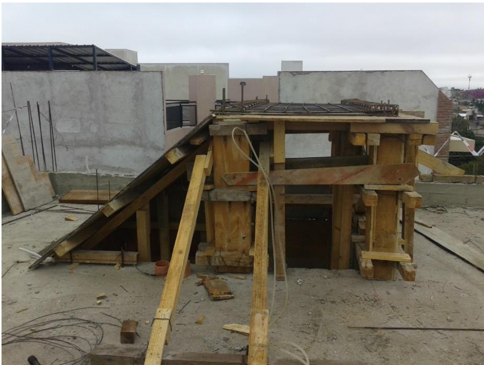
Figura 3.6: Encofrado de columnas y losas de último tramo de escalera.
