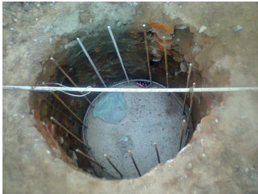
Figura 4.20: Pilote hormigonado.
