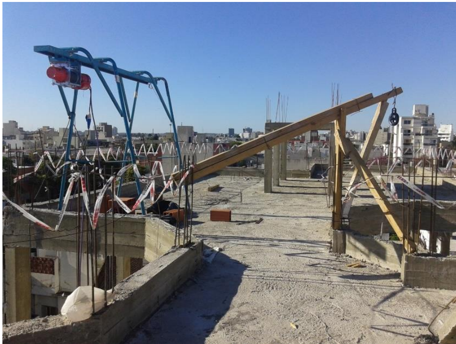
Figura 3.4: Equipos de izado de materiales.
