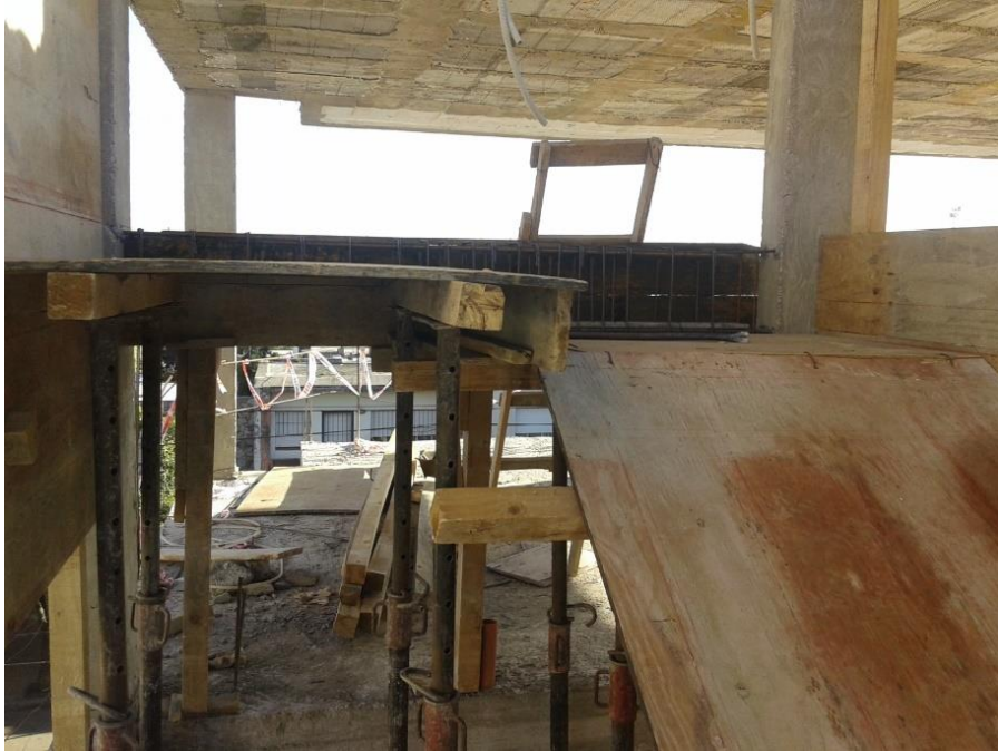
Figura 3.11: Encofrado descanso de escalera.
