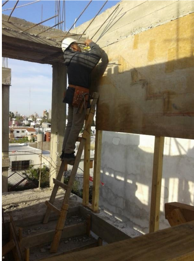
Figura 3.9: Obrero realizando encofrado de escalera.
