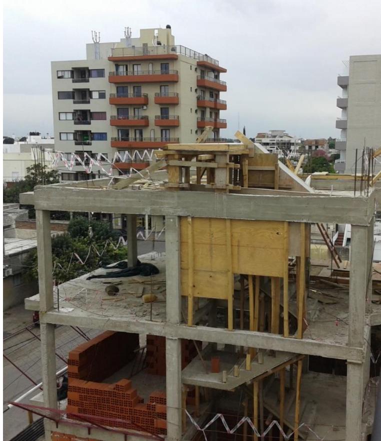
Figura 3.13: Encofrado de escalera.
