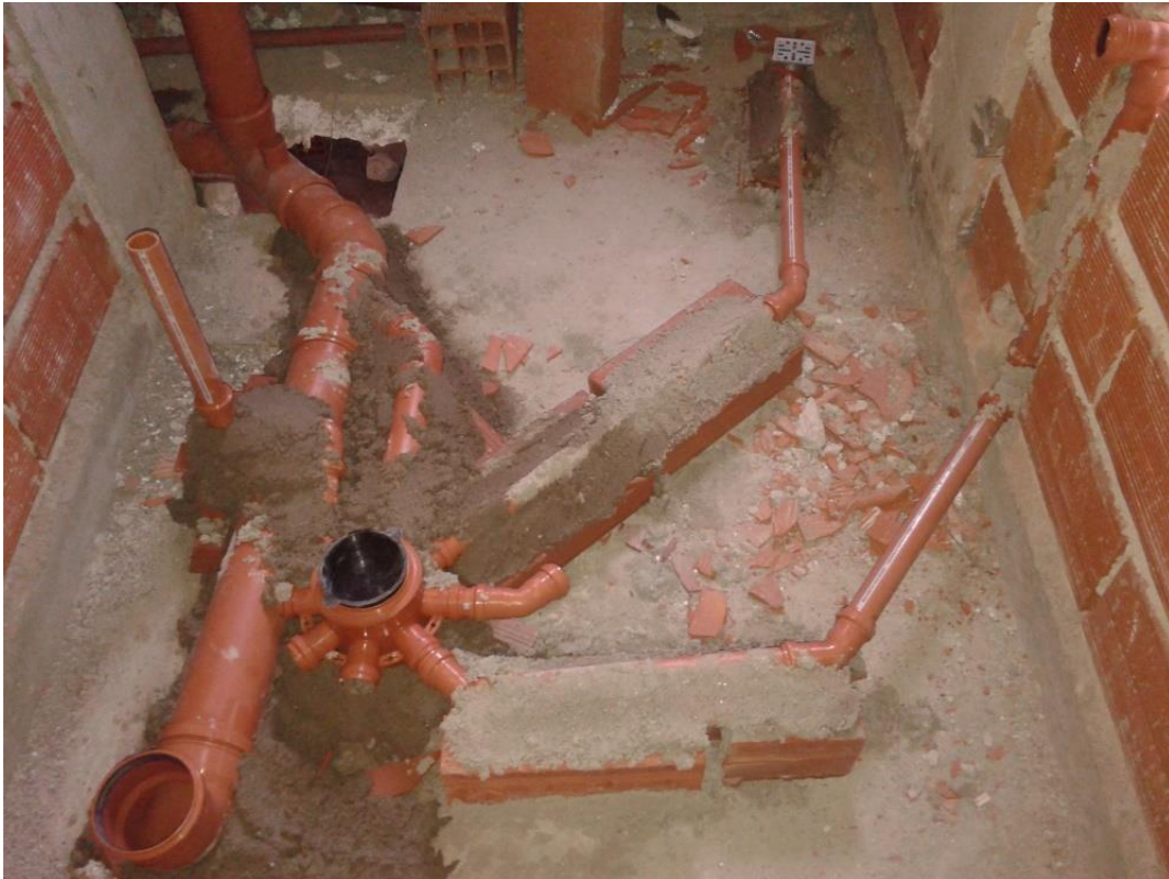
Figura 3.21: Instalación cloacal del baño del Departamento "C" del 1ºPiso.
