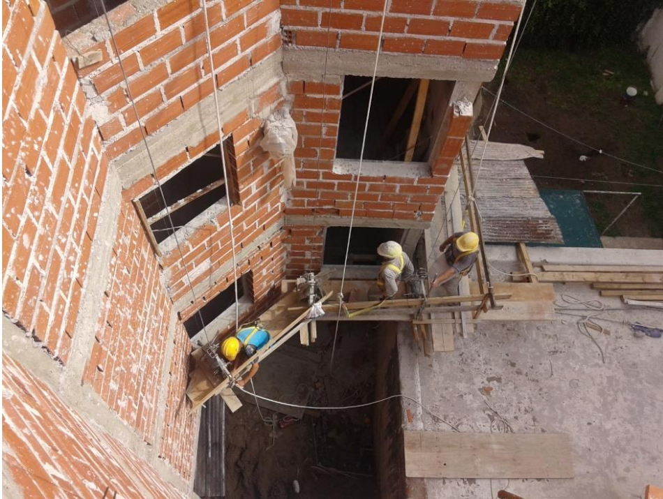
Figura 3.31: Preparación de andamio para revoque exterior.
