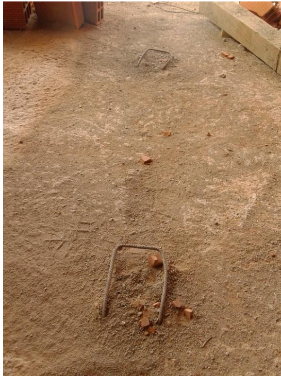
Figura 3.2: Replanteo de mampostería.
