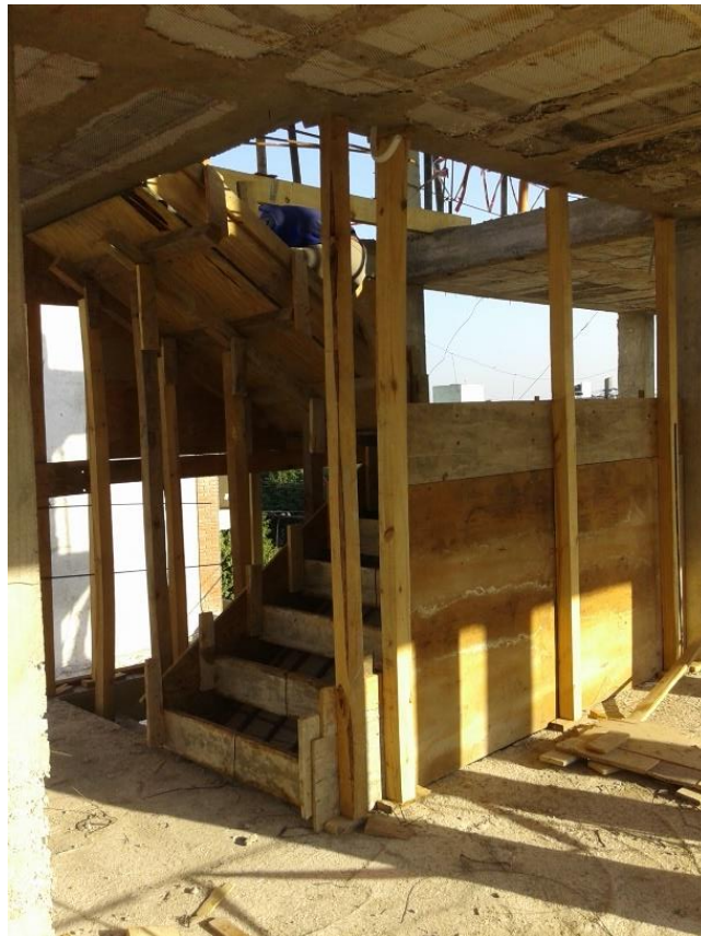
Figura 3.8: Encofrado de escalera.
