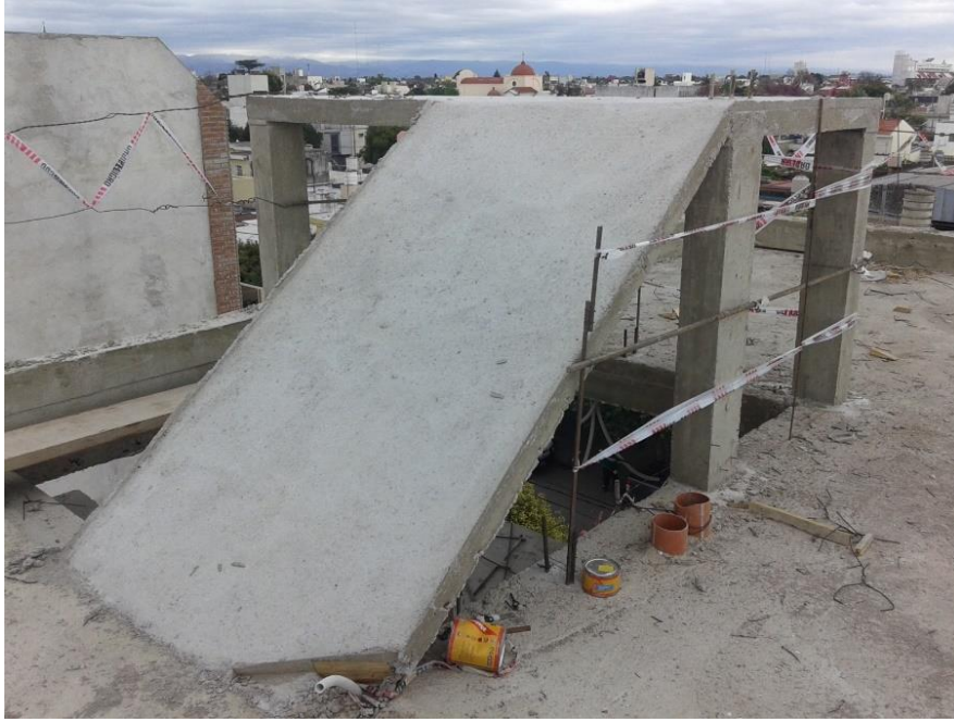
Figura 3.16: Columnas y losas de último tramo de escalera ya hormigonadas.
