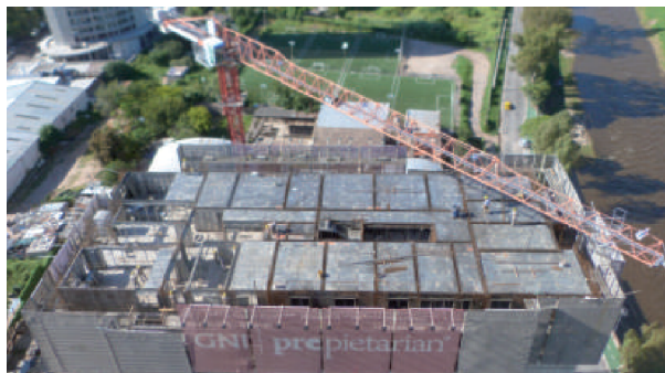
1.2 Fotografía en vista superior de obra en construcción a cargo de ICONSA
