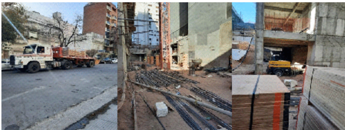
1.17 Materiales acopiados en obra
