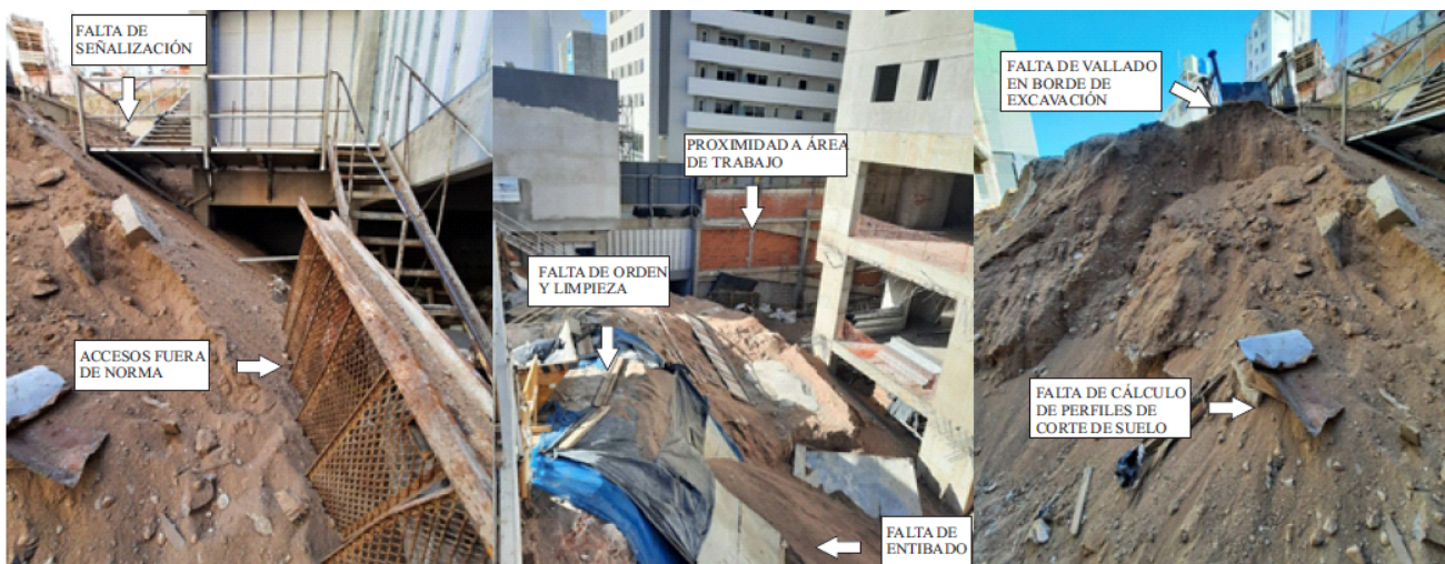
1.24 Fotos en Obra en Área de Excavación
