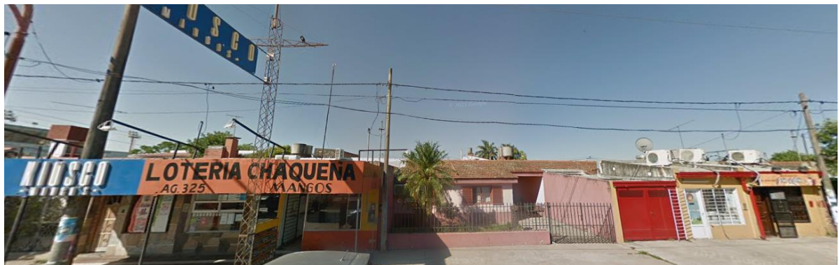
Figura 136. Espacios de permanencia en viviendas individuales a partir de prácticas económicas. Fuente: Google Street View.
