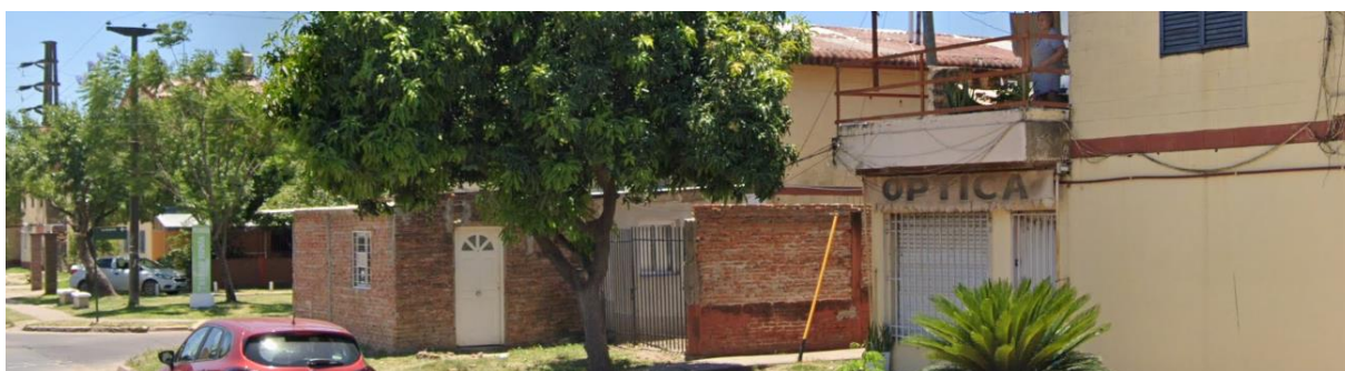
Figura 96. Ocupación del espacio exterior de las viviendas por actividades económicas. Fuente: Google Street View.
