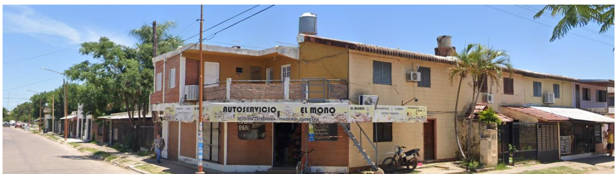
Figura 29. Obstaculización de la circulación barrial por actividades económicas. Fuente: Google Street View.
