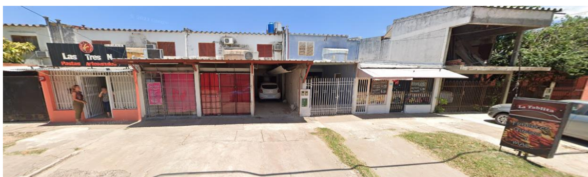
Figura 56. Viviendas concebidas como objetos modificables por actividades económicas.
