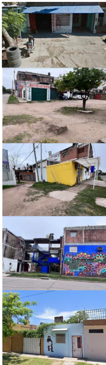
Figura 74. Transformaciones de espacios comunes para adaptación a actividades económicas. Fuente: elaboración propia.
