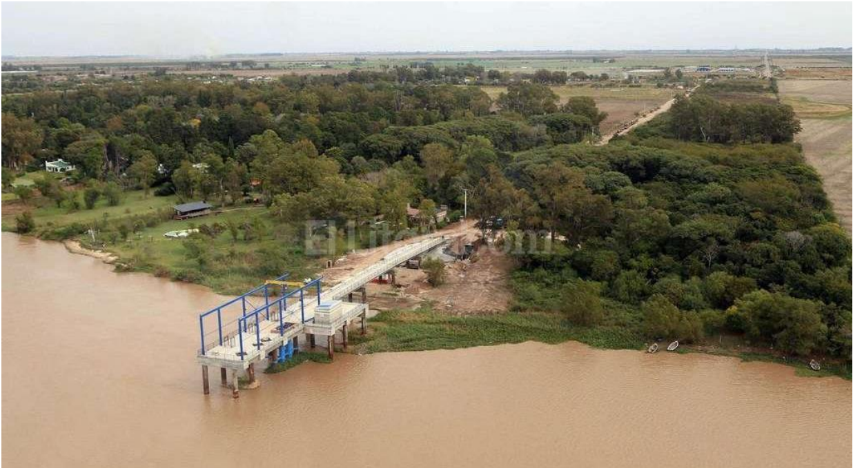
Figura Nº 4 Obra de Toma Acueducto Desvío Arijón
