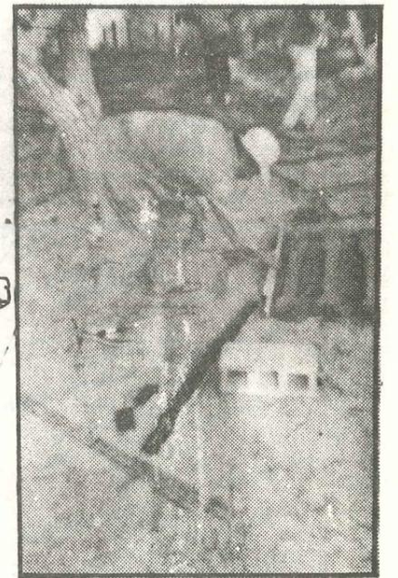
Los moldes empleados se hacen con hierro ángulo (en la construcción del techo, fondo y laterales); y moldes de caño chato para las patas y vigas.
