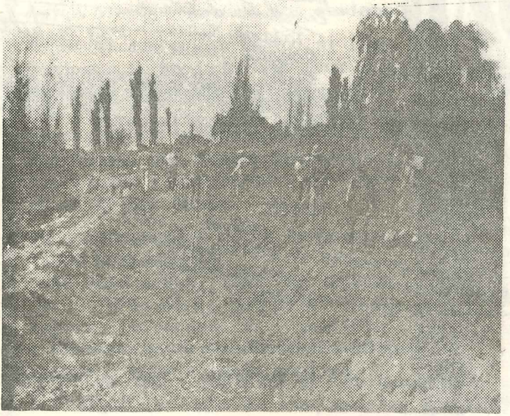
INTEGRANTES DE LOS GRUPOS DE MEDANITOS TRABAJANDO EN LA CONSTRUCCIÓN DEL CANAL QUE TRAERÁ EL CAUDAL DE AGUA QUE HARÁ FUNCIONAR EL MOLINO.
