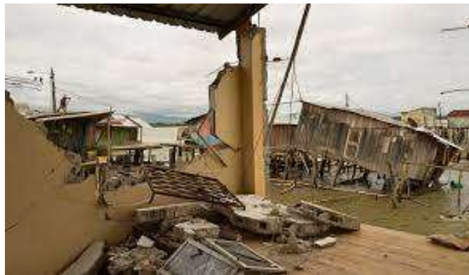
Figura 40. Viviendas colapsadas post terremoto de diferentes materiales. (Foto cortesía).
