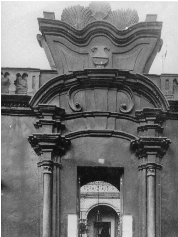
Casa de los Allende de calle Ituzaingo demolida en 1967
