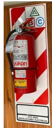
Figura 25: Gabinete de Fonoaudiología Figura 26 Extintores tipo ABC con su correspondiente ficha de control
