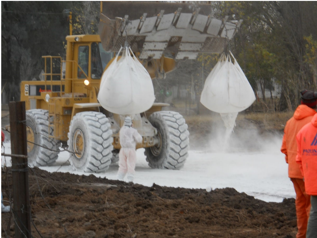
Figura 3.8: Estabilización del suelo de subrasante con cal durante la construcción del cierre de Circunvalación en la Ciudad de Córdoba, Argentina (2011).
