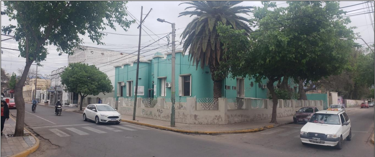
Figura 8 Fotografía Fachada vista desde la esquina de Pelagio B. Luna y Santiago del Estero
