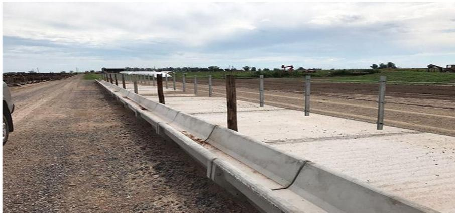
Figura 11: Disposición de comederos con guardapolvo de cemento.
