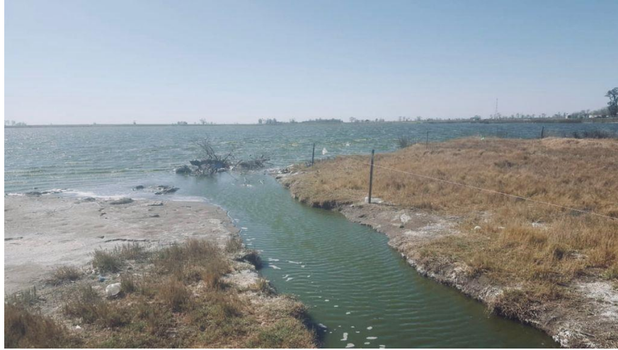
Fig. 19. Canalización de la laguna “Los Mellizos” (Foto propia, 2021)
