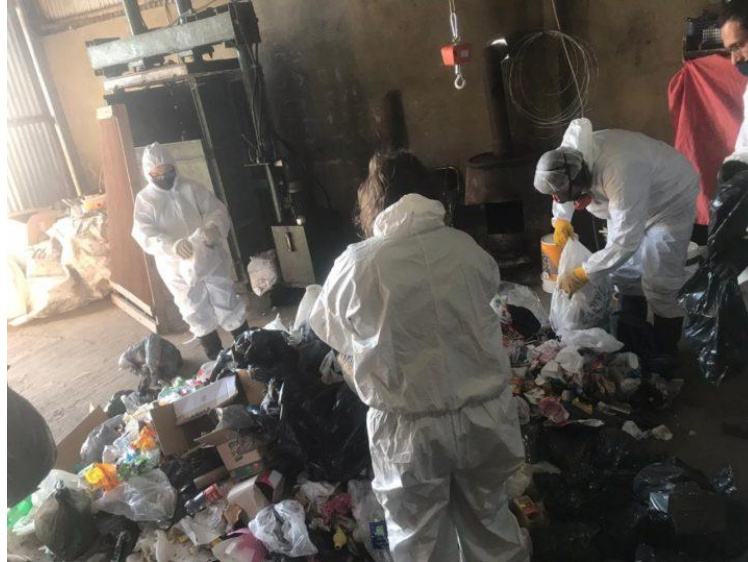
Fig. 9. Trabajos en la planta de reciclado (Municipalidad de Laborde, 2020)
