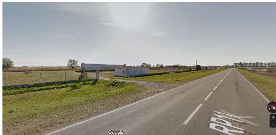
Fig. 11. Planta de separación de RSU, ubicada sobre la RP N° 11, camino a Wenceslao Escalante (Google, 2021)
