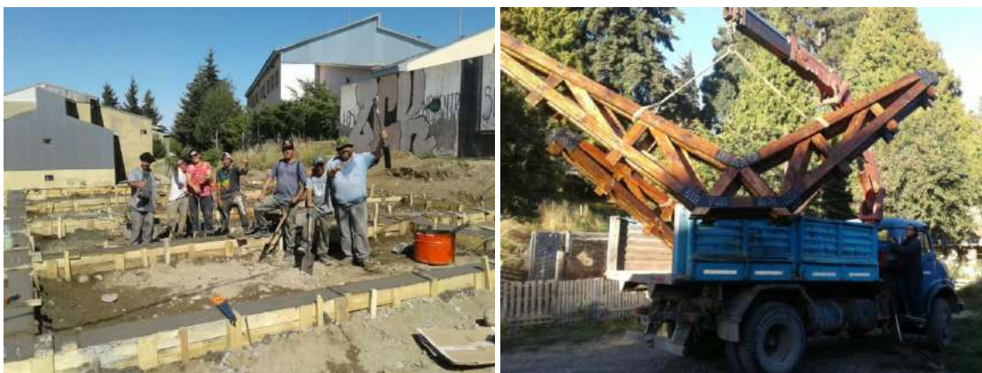
Figura Nº58: Inicio en las tareas de construcción y montaje del SUM en Barrio 96 Viviendas. (Fuente: Archivo fotográfico del Programa de Investigación “Co-construcción del Conocimiento”).
