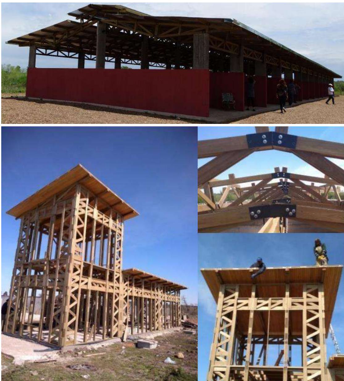
Figura Nº42: Montaje definitivo de los componentes de madera para el galpón de reciclaje y una oficina a partir de la articulación con el sector gubernamental. (Fuente: Archivo fotográfico del Programa de Investigación “Co-construcción del Conocimiento”. Dir: Paula Peyloubet).
