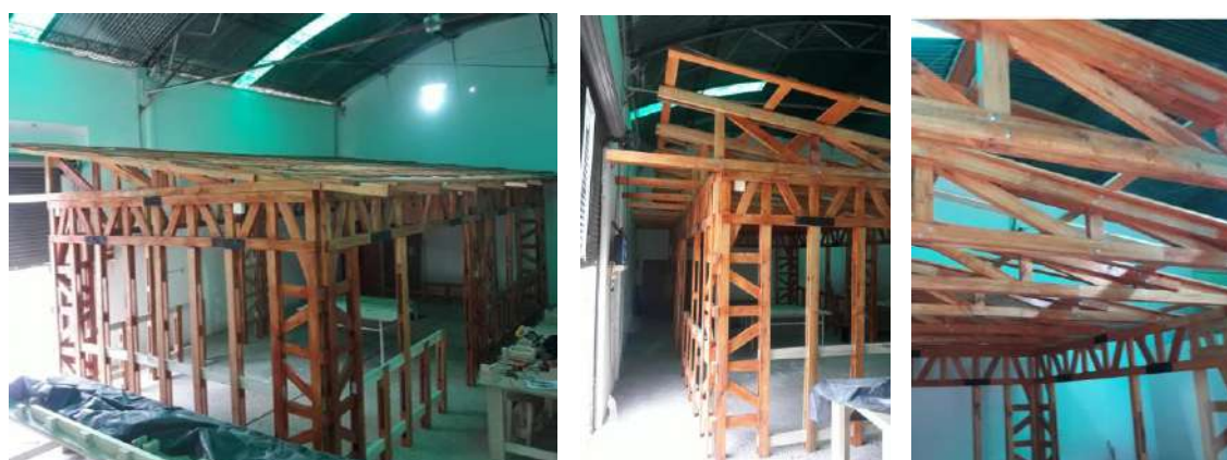
Figura N°29: Montaje módulo experimental Showroom en galpón de la Cooperativa del Delta. (Fuente: Archivo fotográfico del Programa de Investigación “Co-construcción del Conocimiento”).
