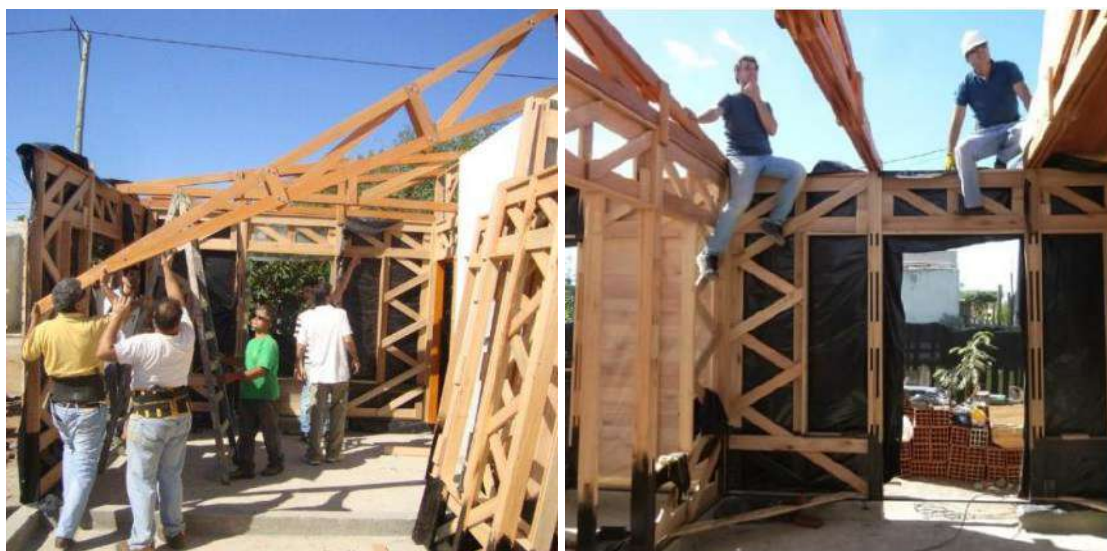
Figura Nº34: Diseño y desarrollo de la tecnología. Montaje y construcción de viviendas en Villa Cresto. (Fuente: Archivo fotográfico del Programa de Investigación “Co-construcción del Conocimiento”).
