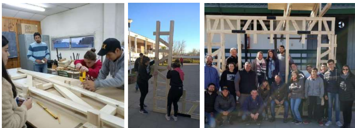
Figura Nº26: Encuentro Productivo. Armado de matrices, componentes y montaje de un módulo experimental en Villa Paranacito. (Fuente: Archivo fotográfico del Programa de Investigación “Co-construcción del Conocimiento”. Dir: Paula Peyloubet).
