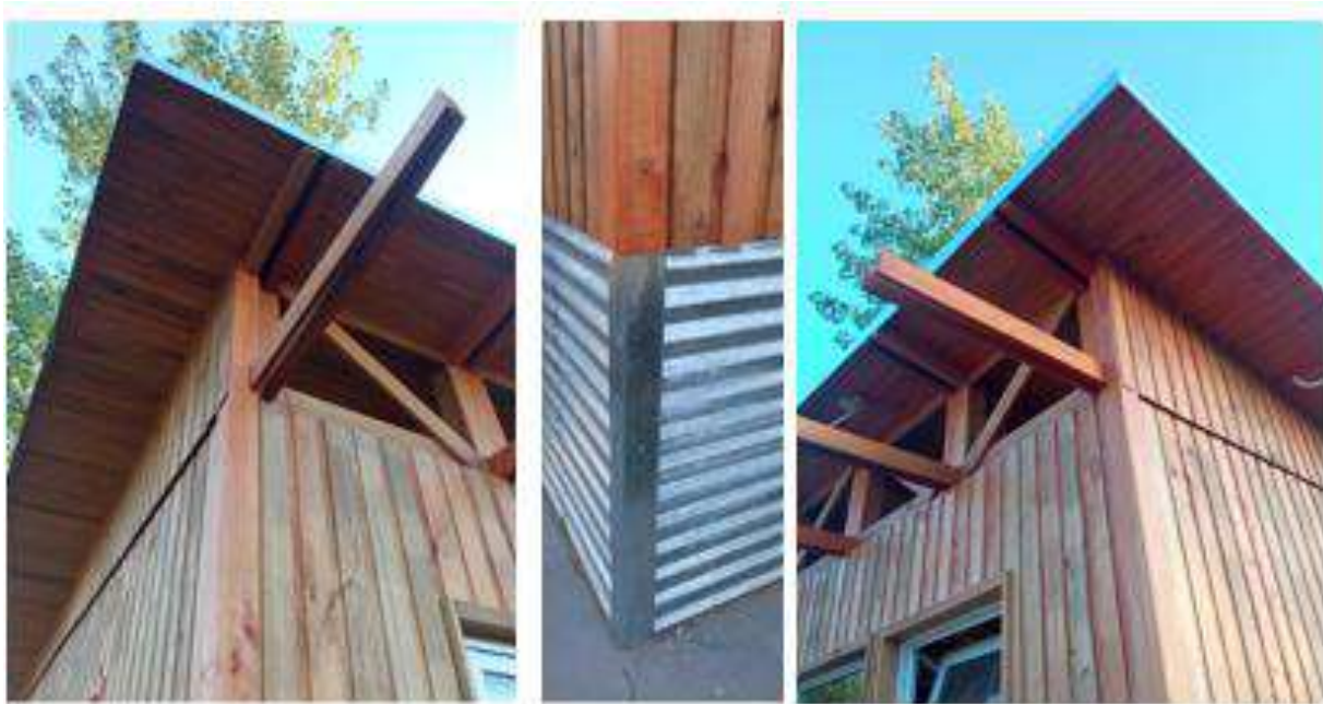
Detalles constructivos del Showroom: zócalo de chapa, fachada de madera y aleros de protección.
