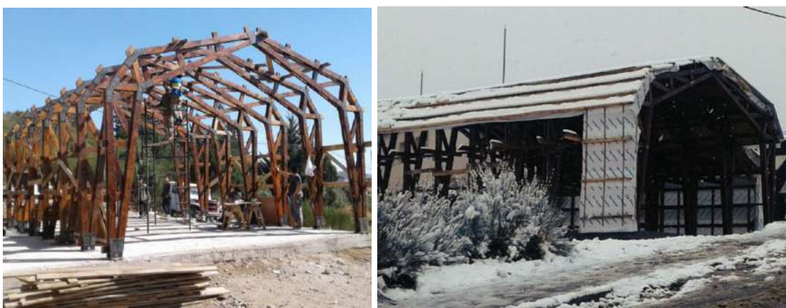
Figura Nº59: Avance en las tareas de construcción y montaje del SUM en Barrio 96 Viviendas. (Fuente: Archivo fotográfico y documental del Programa de Investigación “Co-construcción del Conocimiento”).
