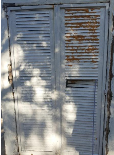
Figura 15: Vista externa de la puerta Este.
