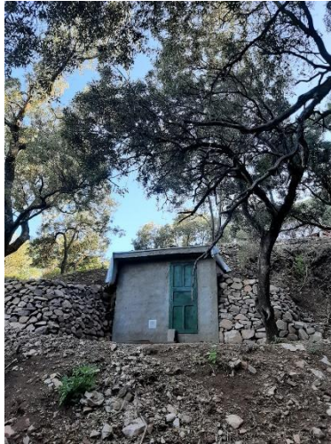
Figura 24: Vista externa del sótano.
