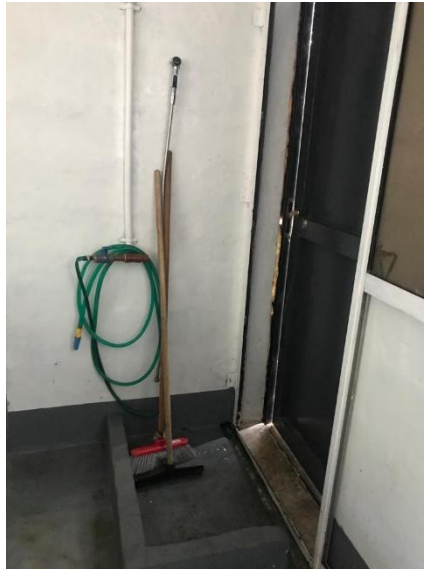
Figura 12: Vista del ingreso, lava botas, y canaleta de desagüe.
