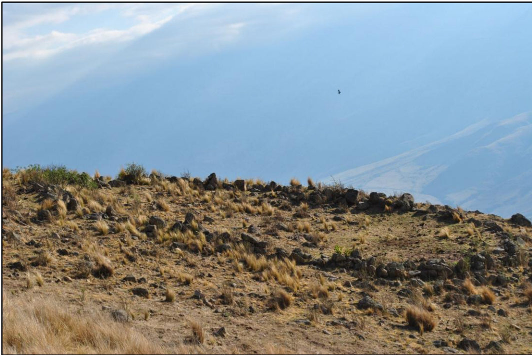
Figura V.24. Esta fotografía da cuenta de la buena conservación de la estructura. En algunos tramos del muro se observa la superposición de rocas.
