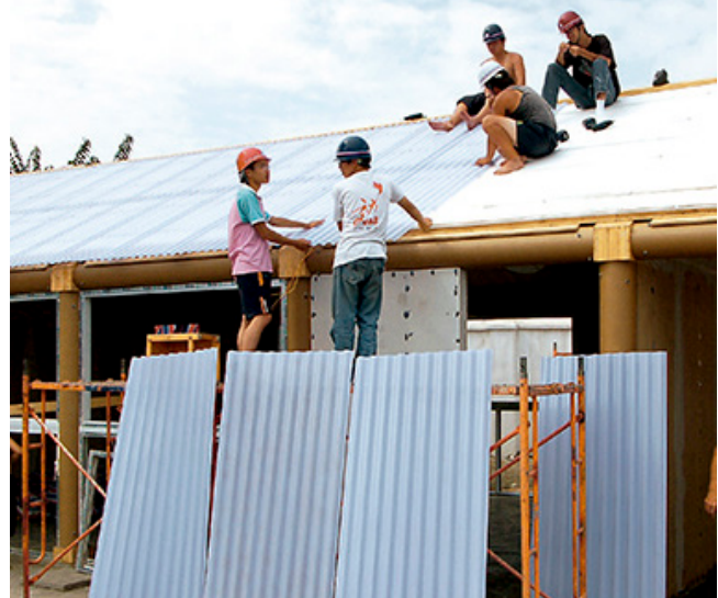
Figura 38: Etapa de construcción de la Escuela temporal en Hualin
