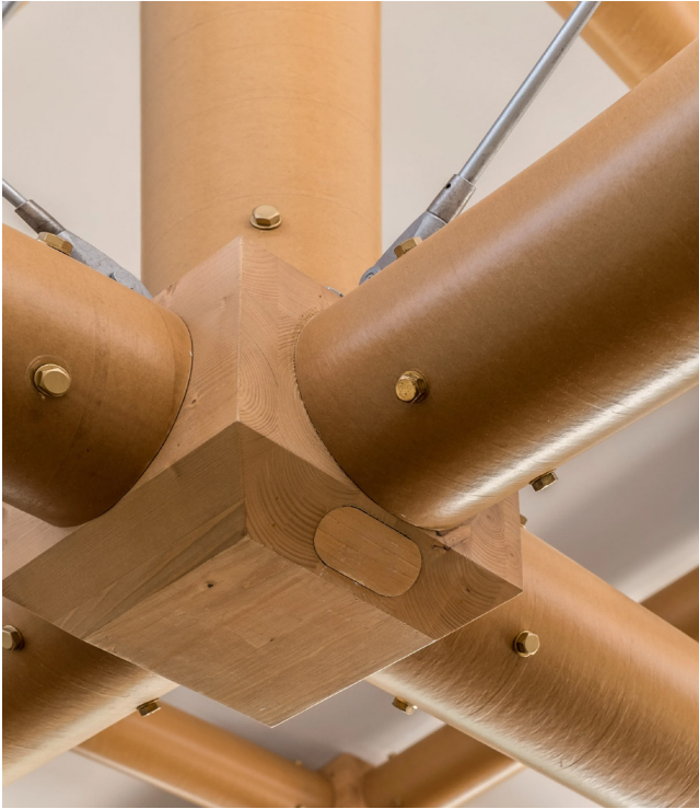
Figura 42: Unión de tubos del IE Pabellón
