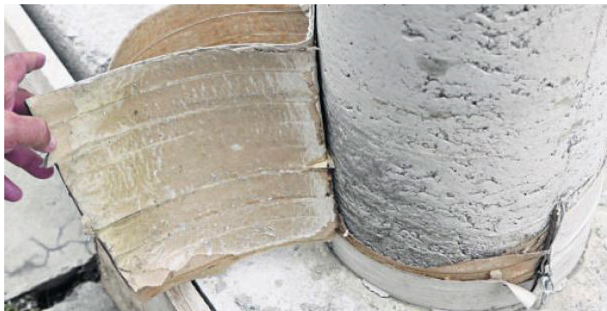
Figura 5: Encofrado de columna de hormigón
