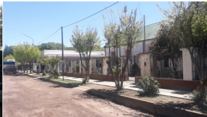
Imagen 6. Serra, M.F. (2019) Fachadas de las escuelas (primaria y secundaria), desde la esquina [Fotografía]. Santa Fe, Argentina.
