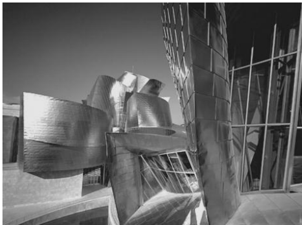
(Fig. 1) Frank Gehry. Museo Guggenheim. Bilbao. "Escamas" como piel del edificio. (Configuración-Realización-Métrica-Localización)
