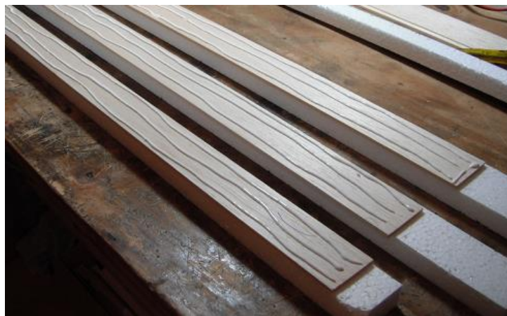
Figura 15: Encolado de platabandas de los largueros.
