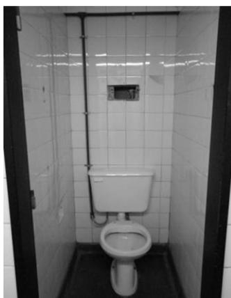
**Figura 11:** Tendido de cañerías externas. Mochilas de Inodoros a reemplazar.
