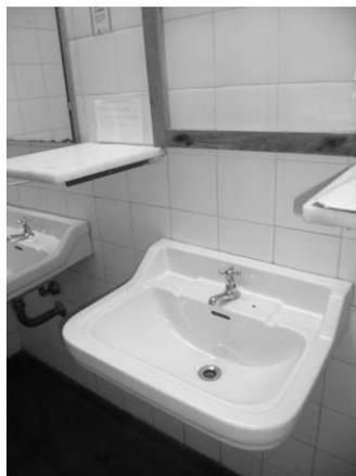
**Figura 16:** Vista de lavatorios baño 3. Grifería de baja eficiencia.
