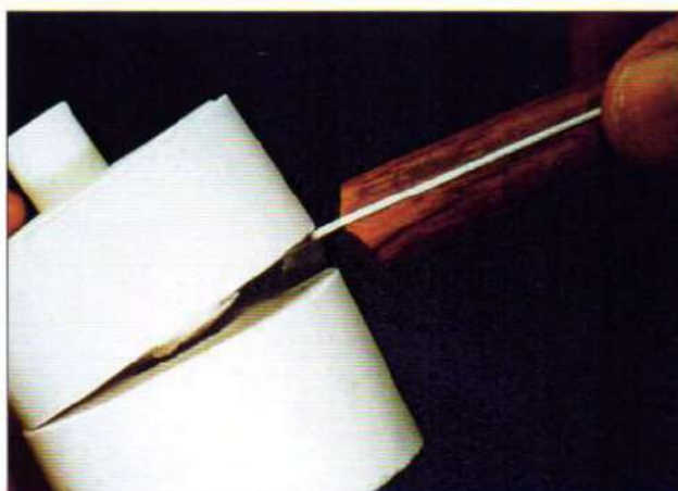
Figura 49: Separación del aro en la marca de la altura del taco de inyección.
