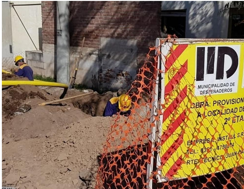
Fotografía 4: Cartel de obra en la vía publica en la gestión actual 2021.
