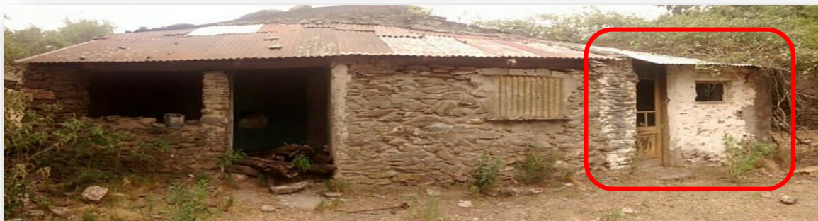
Imagen 5.30 : vista de la habitación que posiblemente funcionó para albergar al cura.
