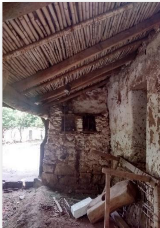
Imagen 5.10: vista lateral de la galería de la estructura original.
