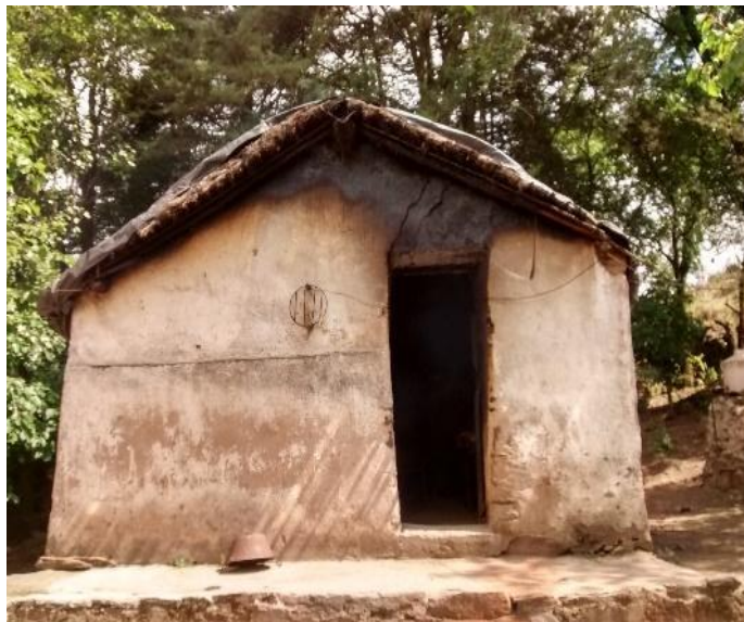
Imagen 5.1 : vista a la entrada de la cocina
