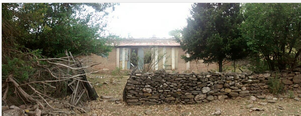
Imagen 5.32 : vista al muro que rodea la propiedad
