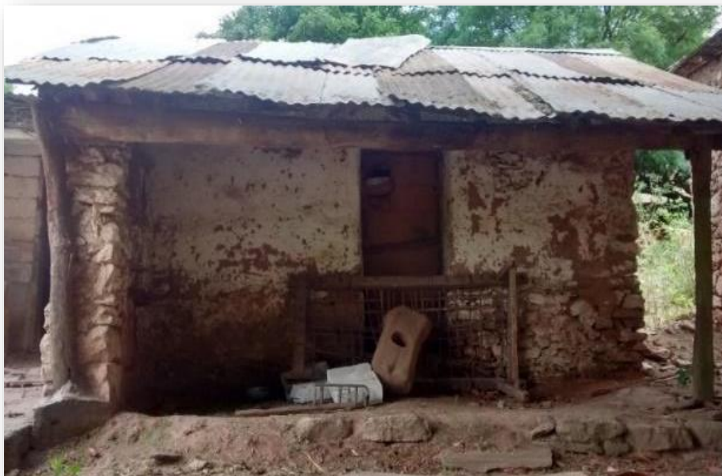
Imagen 5.9: frente de la estructura original de Pantanillo
