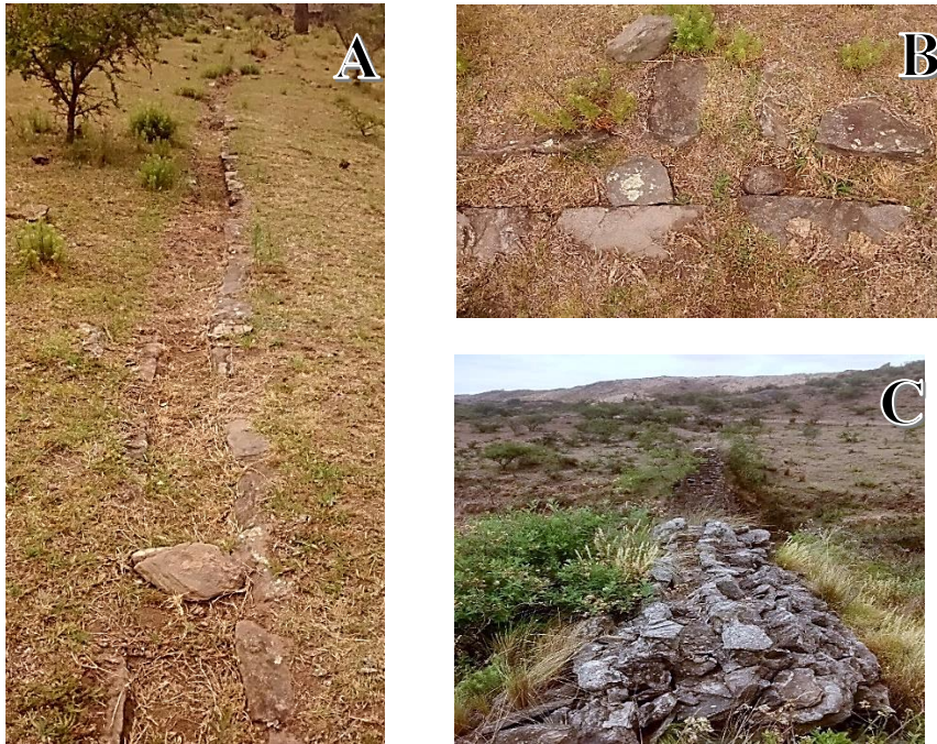
Imagen 5.35 : A, canal de riego. B, bocatoma para desviar el agua a campos de cultivo. C, sector del canal donde se hallaba el caño de hierro, que se dirigía al otro lado de la barranca.
